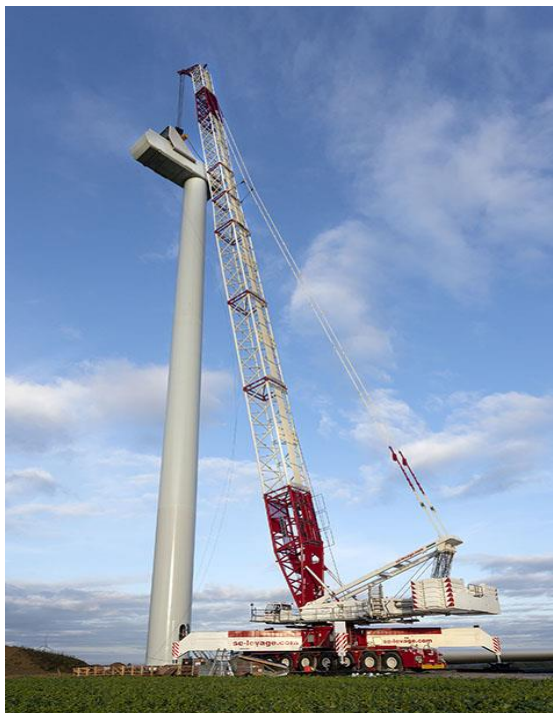
Figura 13 – Una gru tipo Liebherr 1750 durante l’installazione di un generatore eolico
