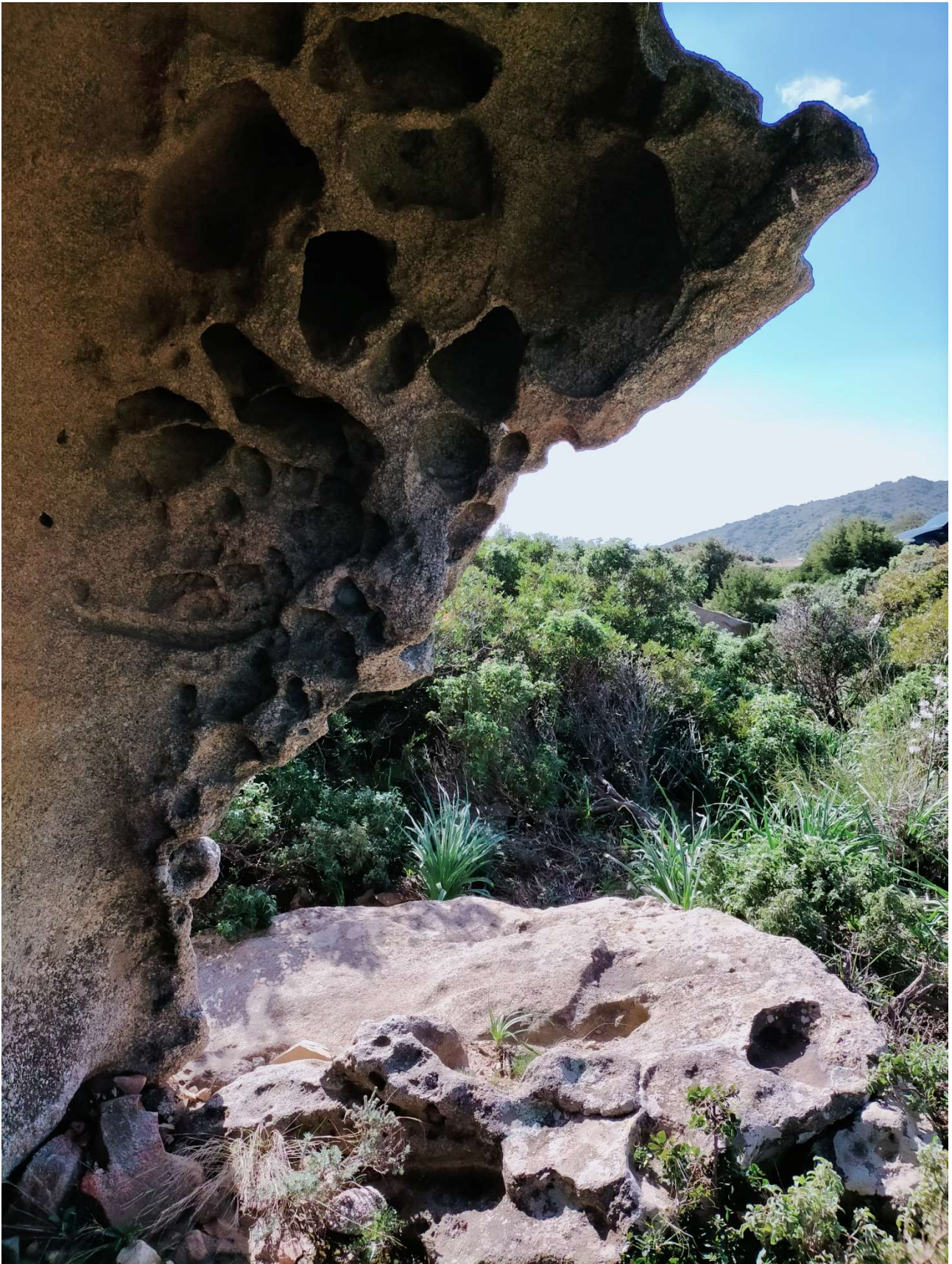
Figura 13-Tafone visto dall'interno, si può notare come il processo parta da un fenomeno iniziale di alveolizzazione
