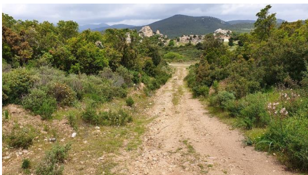
Figura 87. Tracciato del cavidotto presso la turbina WTG006, vista da S.
