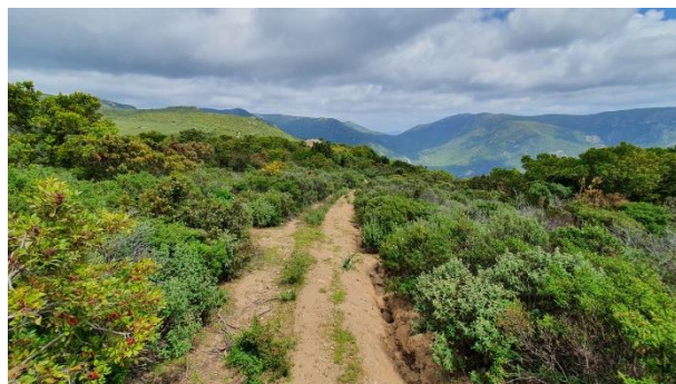
Figura 88. Tracciato del cavidotto presso la turbina WTG007, vista da SW.
