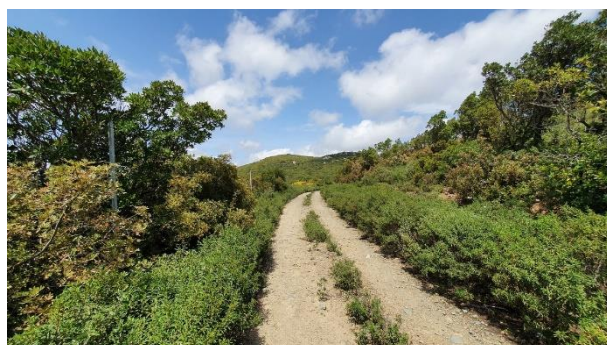
Figura 84. Tracciato del cavidotto presso la turbina WTG014, vista da SSE.
