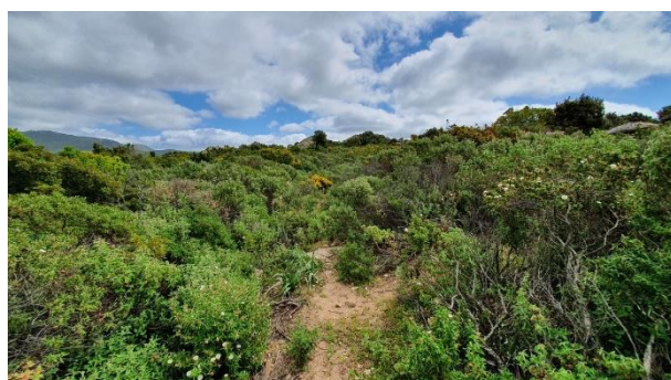
Figura 86. Tracciato del cavidotto presso la turbina WTG005, vista da WSW.
