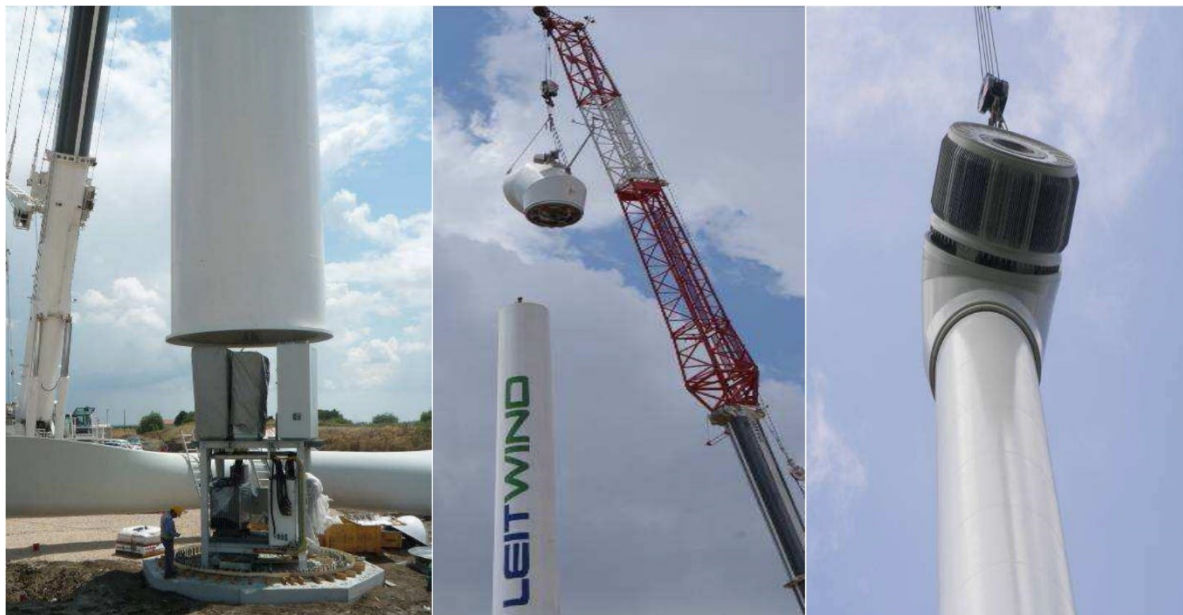
Foto 6 -Montaggio torre
