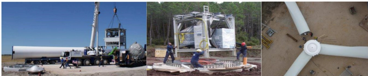
Foto 5 -Assemblaggio aerogeneratore
