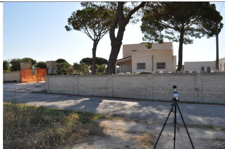
Foto della misurazione. Il fabbricato risulta essere in fase di ristrutturazione al momento del rilievo acustico.
