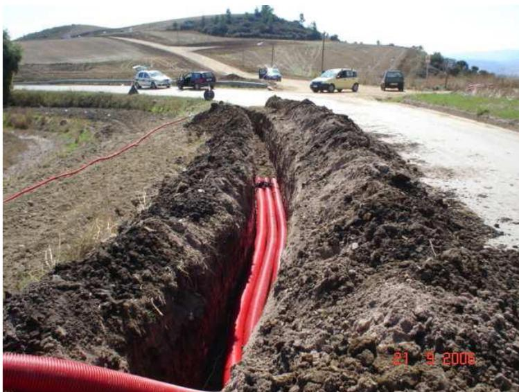
*Fig. 1.1: Foto illustrativa della messa in posa dei cavidotti MT*
