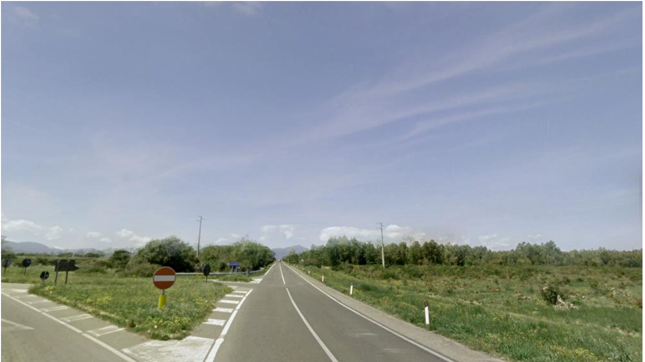
Figura 8 - Vista da SS197 - ante operam
