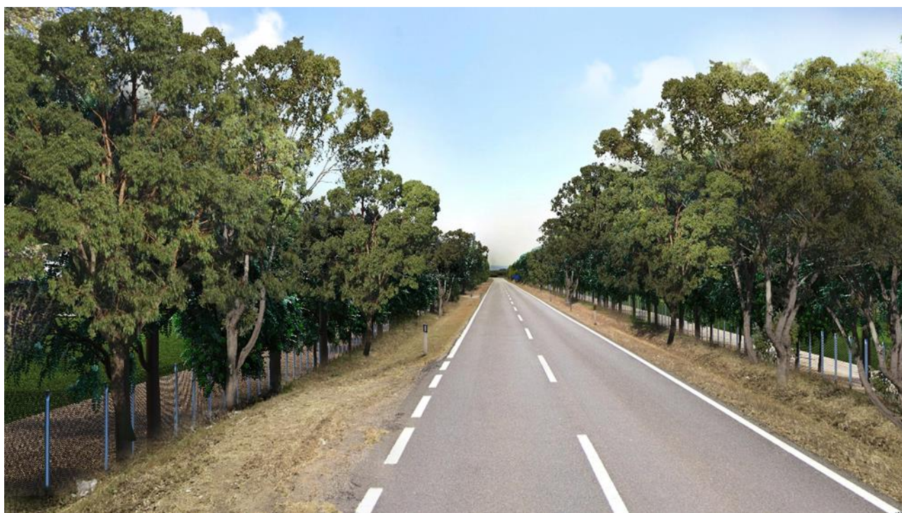
Figura 7 - Vista da SS197 – post operam
