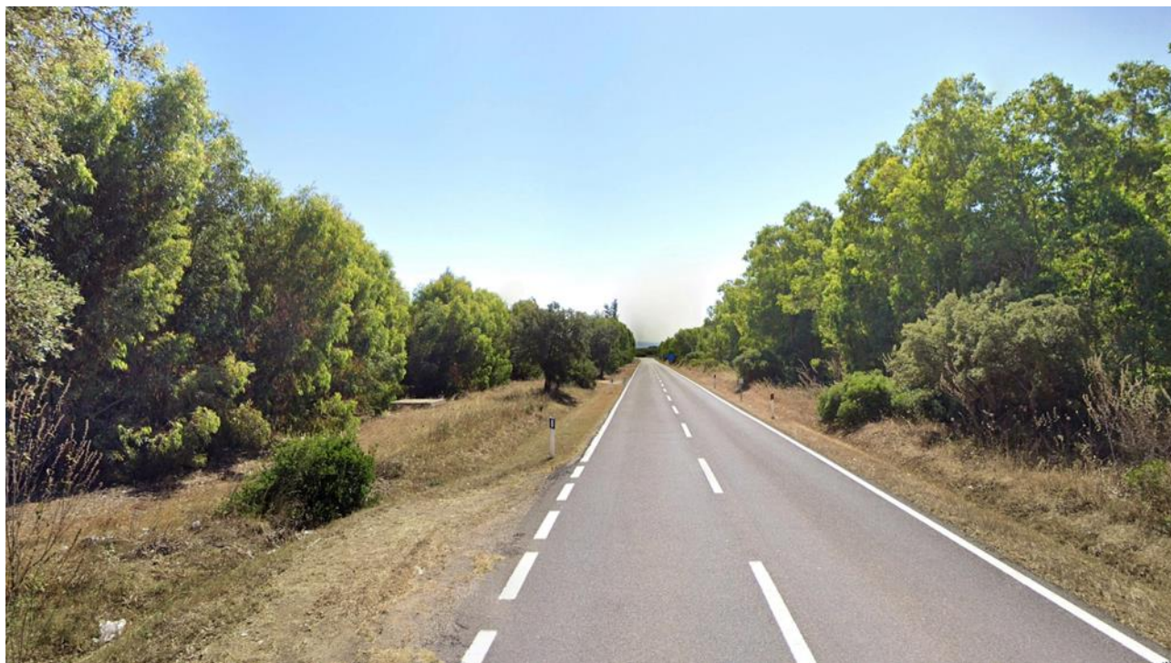
Figura 6 - Vista da SS197 – ante operam
