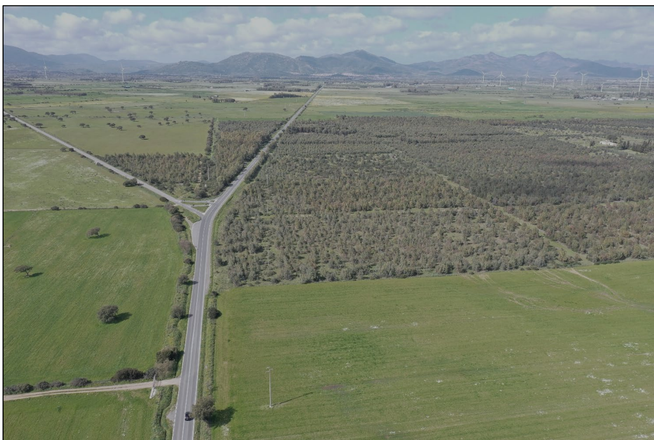
Figura 15: Inquadramento Sito – Vista Aerea da Est con evidenza Incrocio della SS197 con SP4
