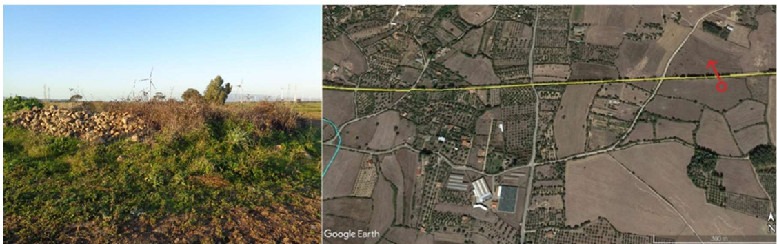
Fig.22 Area dei lavori, nel cerchio rosso il punto di scatto, nella freccia rossa la direzione
