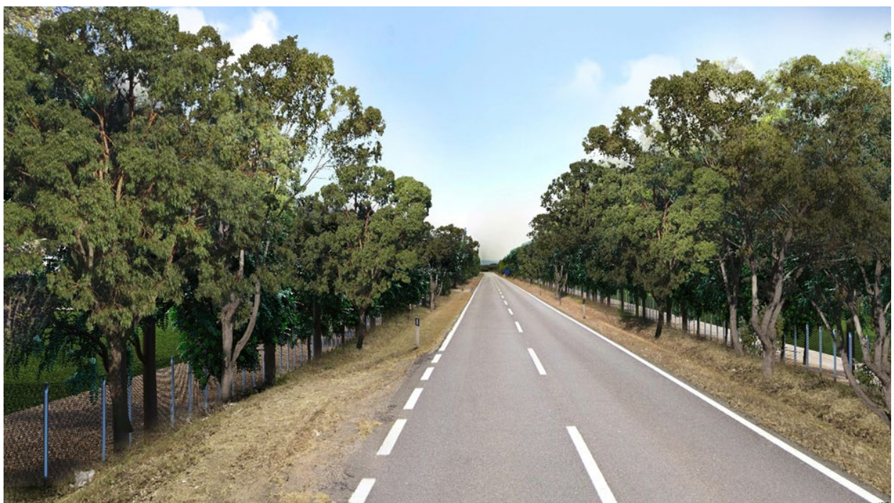
Figura. 10 - Vista da SS197 – post operam
