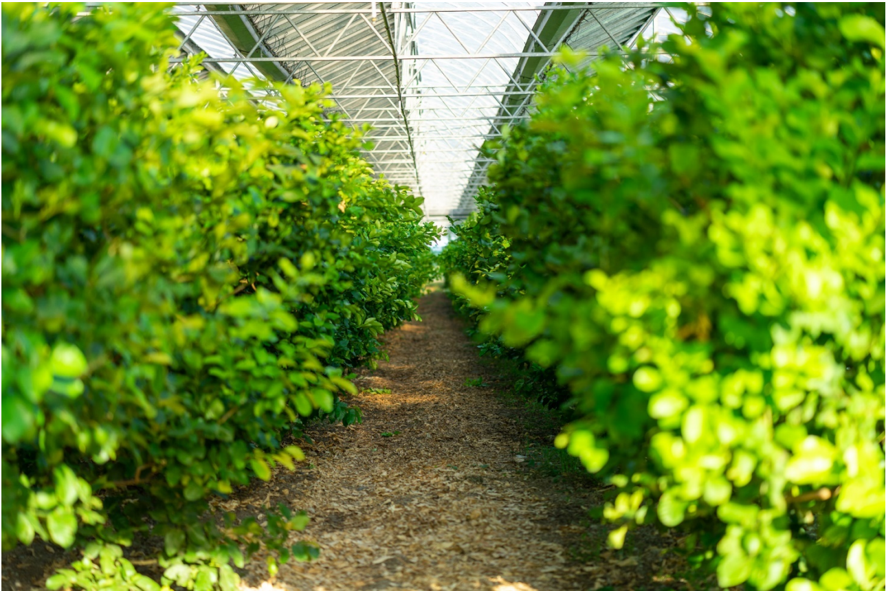
Figura. 5 - Serra fotovoltaica con coltivazione di limoni
