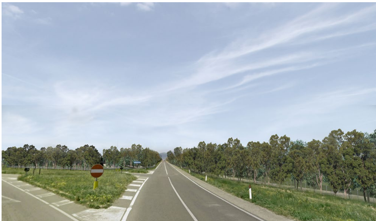
Figura. 12 - Vista da SS197 – post operam
