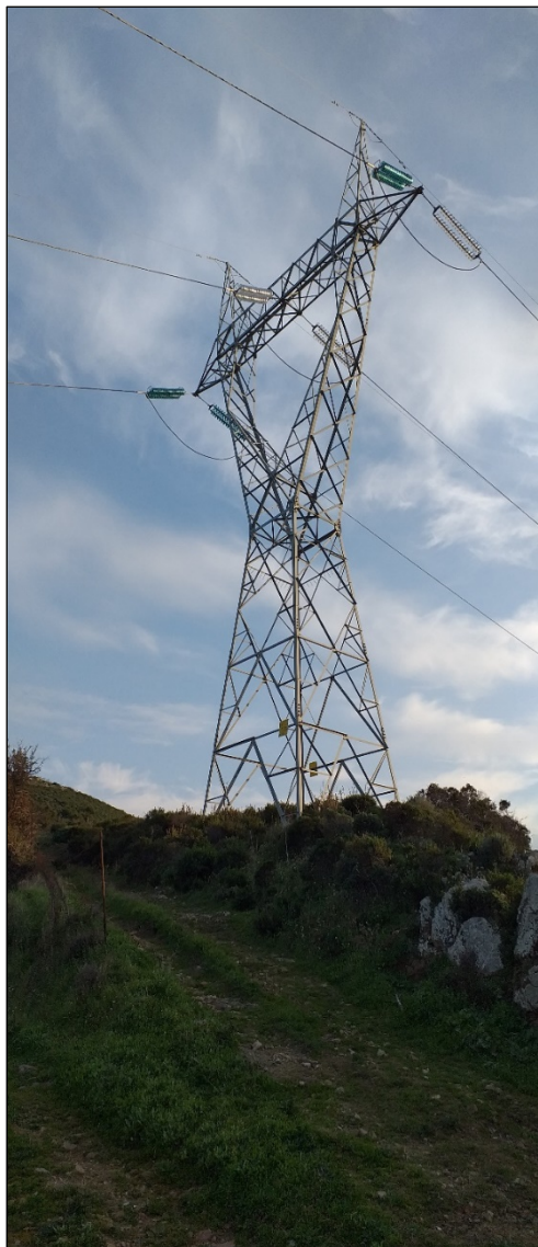
Foto 5 – Sostegno n. 117/14 della linea a 220 kV "Oristano-Sulcis" da sostituire, interno all'area del SIC ITB040031 "Monte
