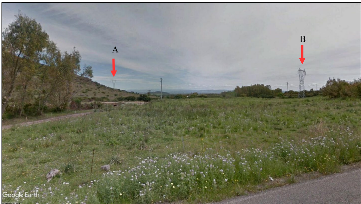
Foto 4 - Nella foto soprastante, tratta da Google Earth, si evidenziano con le frecce rosse i futuri punti di raccordo con la linea AT "Oristano-Sulcis". Il traliccio B si trova al margine di un'area agricola e in prossimità della viabilità ordinaria. Il traliccio A è l'unico elemento interno al perimetro della Rete Natura 2000, come evidenziato nel capitolo seguente.
