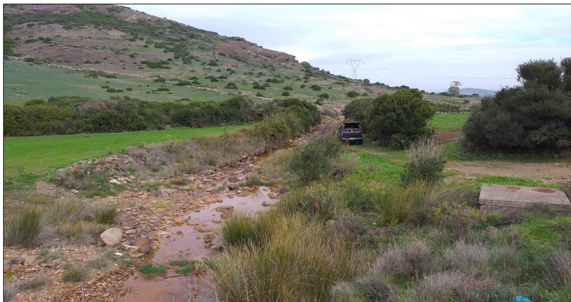
Foto 4: comune di Guspini, vista da sud della linea a 220kV "Oristano-Sulcis" sulla quale saranno eseguiti i raccordi aerei in progetto a 220kV, ricadenti nell'area tutelate del Riu Montevecchio-Sitzerri (identificato nel Codice dei Beni culturali e del Paesaggio come Riu Pratzidus, codice Id 2822) e nell'area dell'organizzazione mineraria (bene identitario ex art. 143 d. Lgs. 42/2004)
