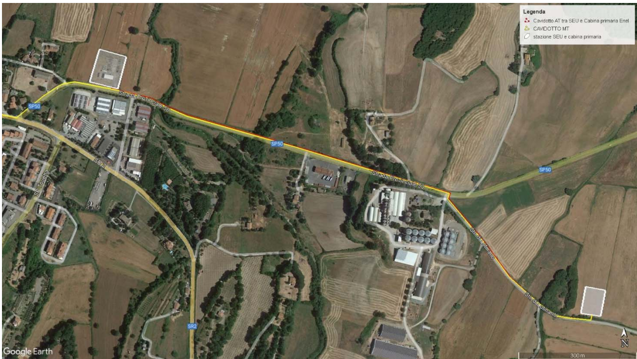
Foto 2- inquadramento stazione di trasformazione e cabina primaria E-distribuzione esistente
