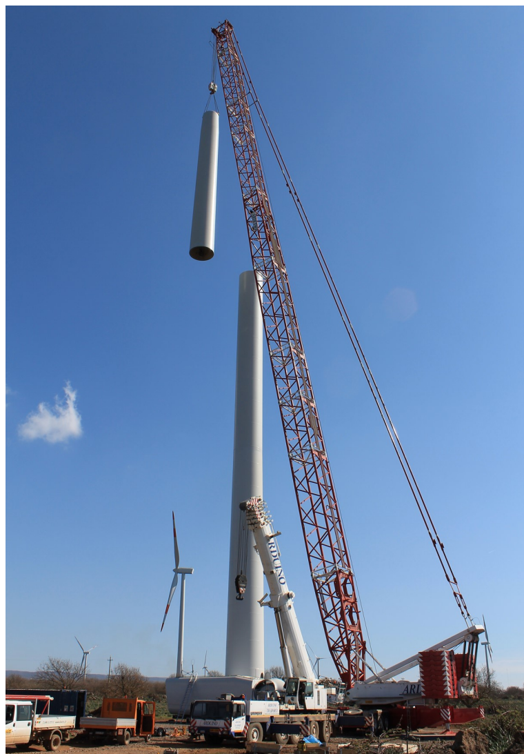
Figura 18: Fase di montaggio della torre
