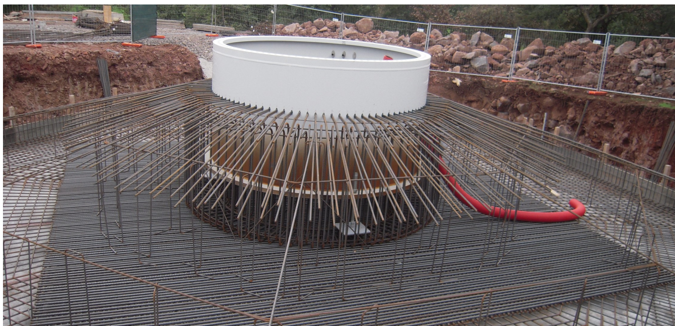
Figura 15: Esempio di fondazione tipo
