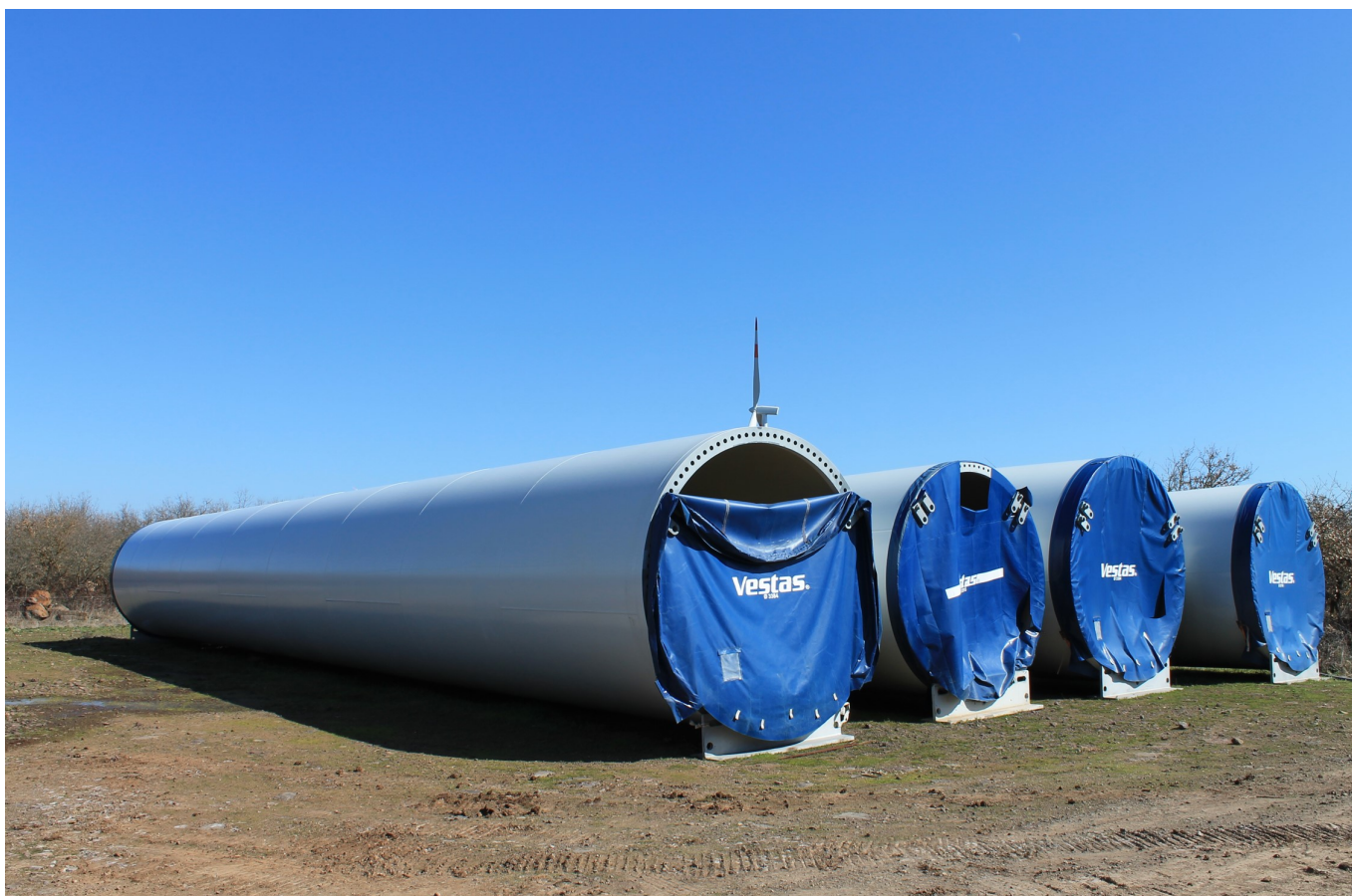
Figura 14: Esempio di area deposito elementi torre
