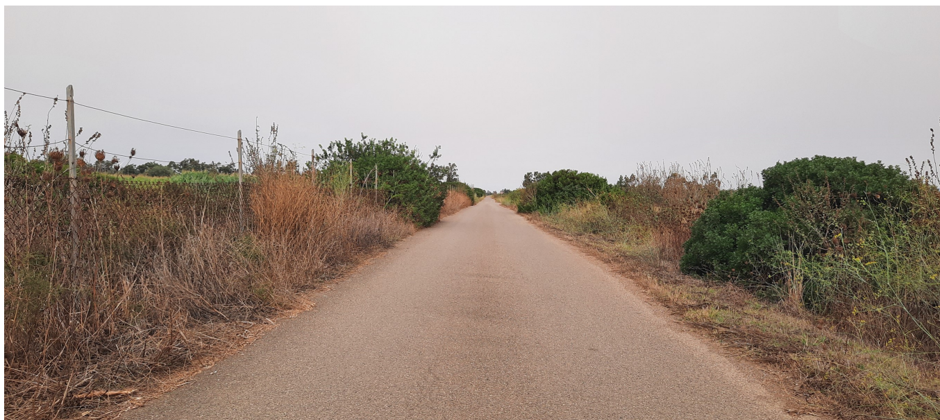
Figura 11: Strada asfaltata interna al parco
