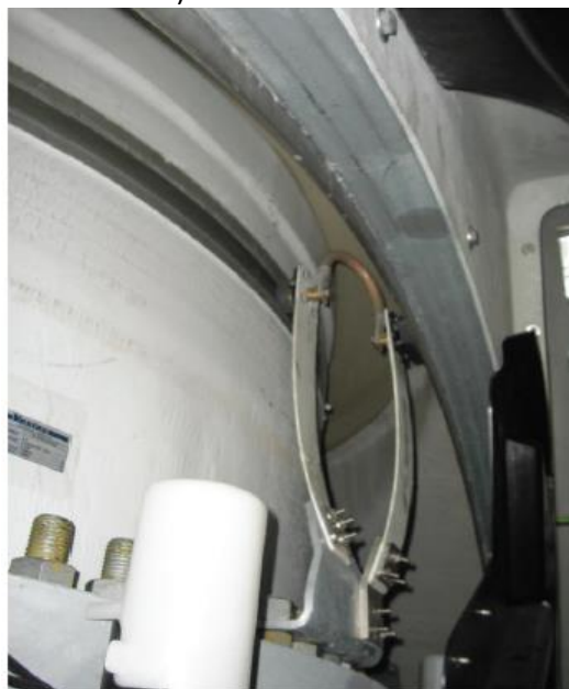
Figura 5.2: LCU tra lame e telaio navicella.
