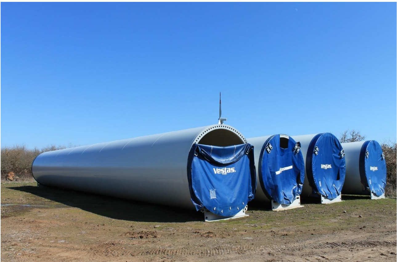
Figura 5-9 - Esempio di area deposito elementi torre
