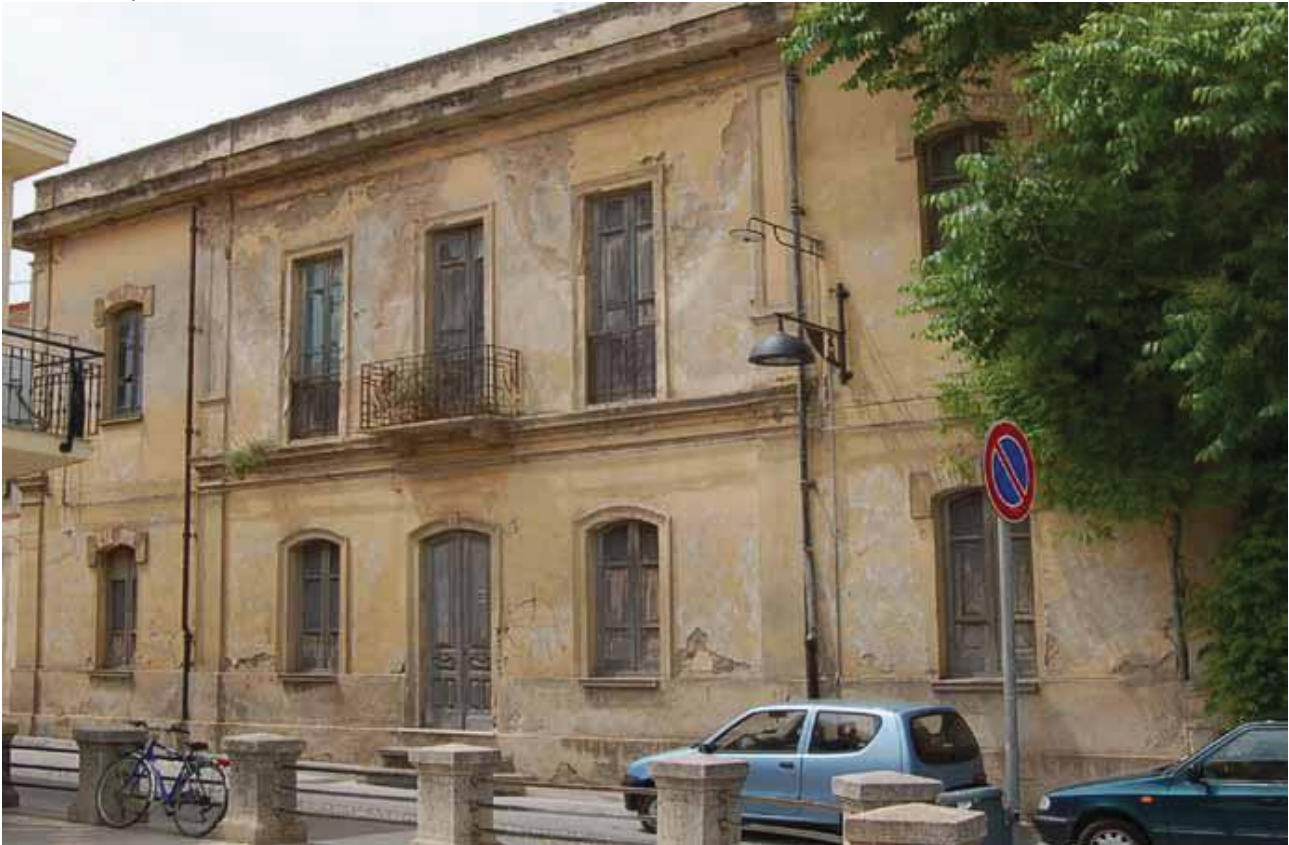
Figura 8-20 - Casa Mereu in via Diaz
