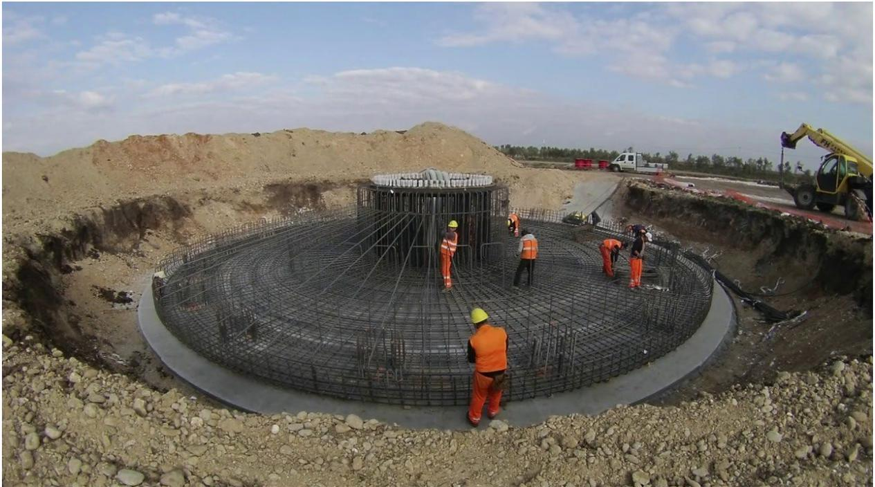
*Figura 5 - realizzazione plinto di fondazione*
