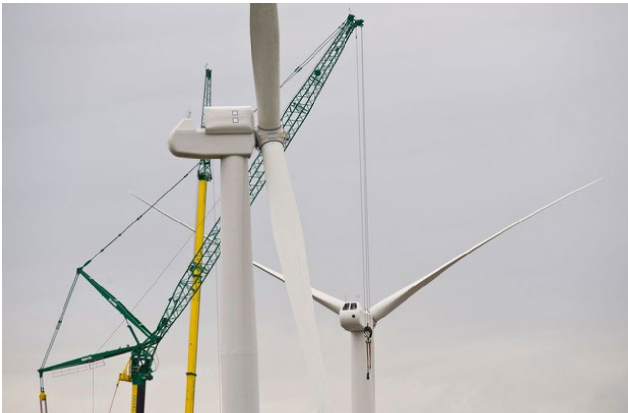
Figura 2- posa in opera aerogeneratori
