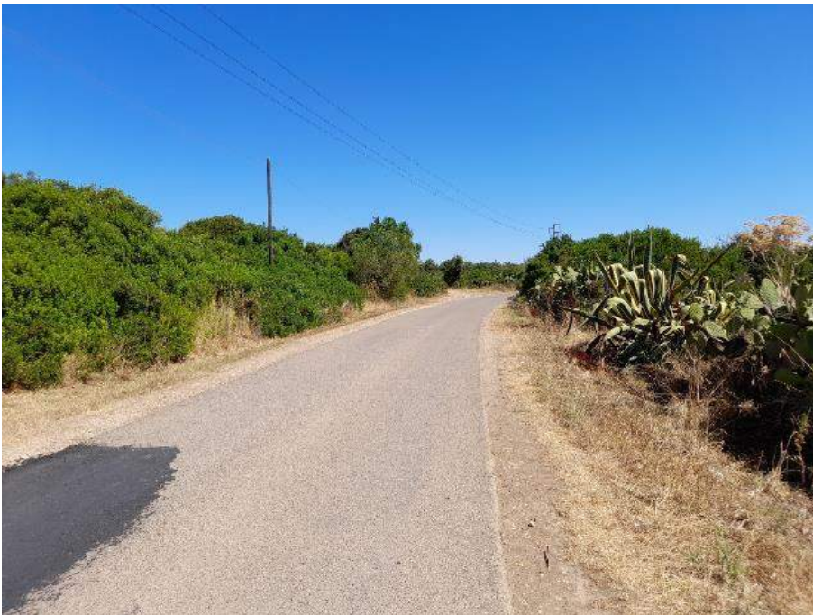
Figura 54 - Tratto III: scatto da P1 verso N
