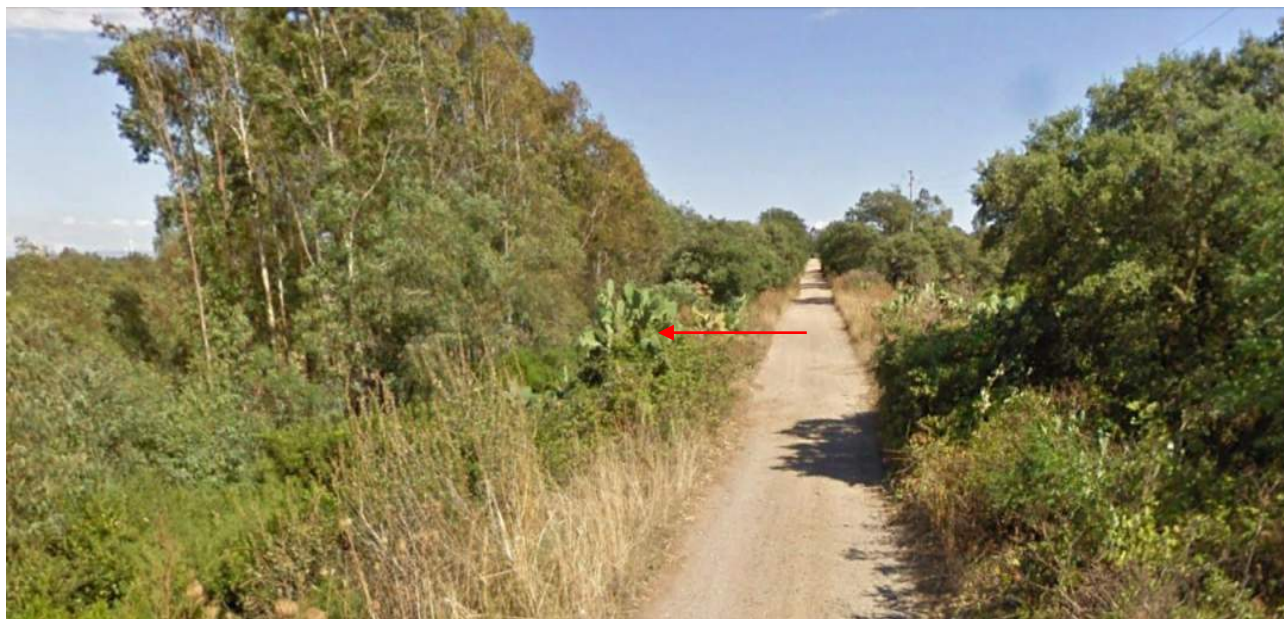
Figura 0.16 – Ultimo tratto del cavidotto lungo strada secondaria che si innesta sulla strada Com.le Meabol e punto di connessione con la cabina RTN. Foto estrapolata da Google Earth in direzione sud-est (P.to 13)
