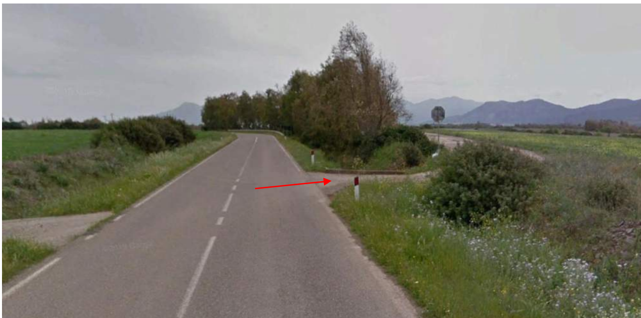
Figura 0.8 – Punto di innesto tra la SP 65 e la Strada Com.le Meaboli lungo la quale prosegue il tracciato del cavidotto. Foto estrapolata da Google Earth in direzione sud-ovest (P.to 7)
