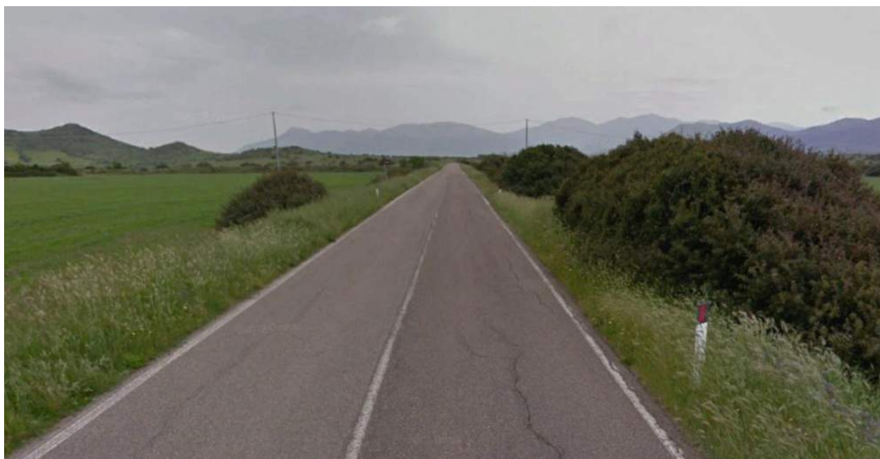
Figura 0.7– Asse provinciale 65 lungo il quale corre il cavidotto. Foto estrapolata da Google Earth in direzione sud (P.to 6)
