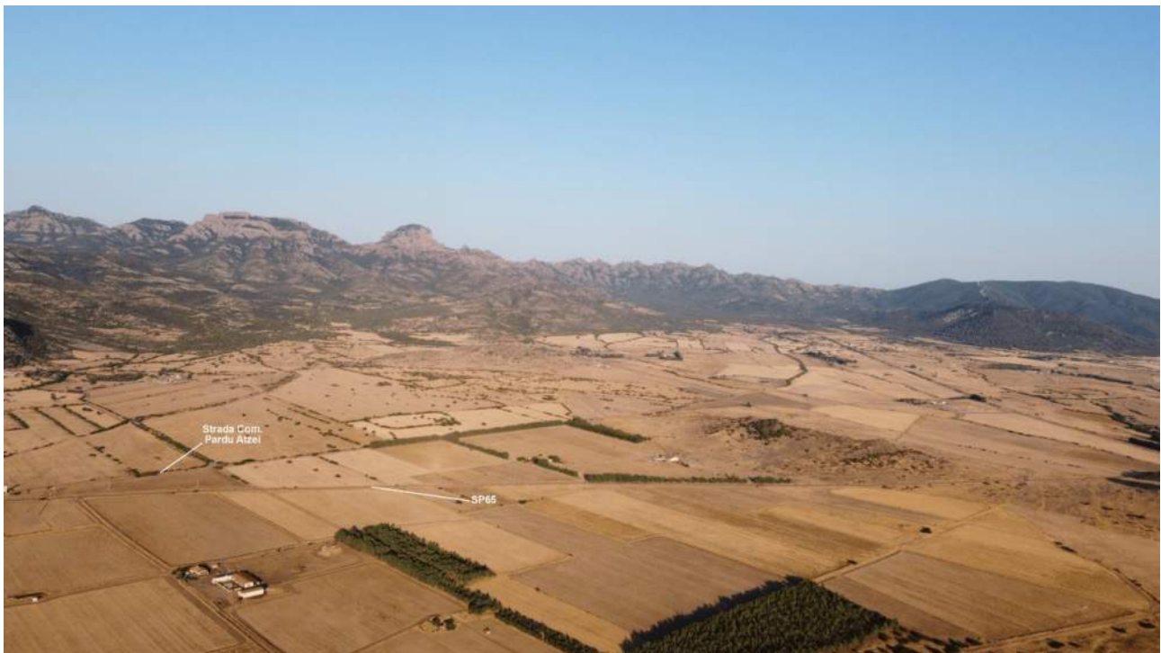
Figura 0.3 – Inquadramento area di impianto. Ripresa aerea da est verso ovest (P.to 2)
