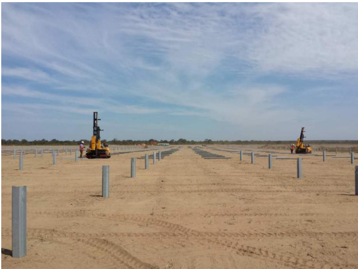
Figura 6.6 – Fase di infissione dei pali con profilo omega (fonte Convert)
