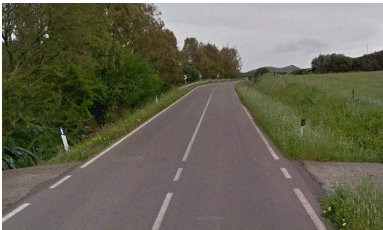
Figura 0.6– Asse provinciale 65 lungo il quale corre il cavidotto. Foto estrapolata da Google Earth in direzione sud-est (P.to 5)
