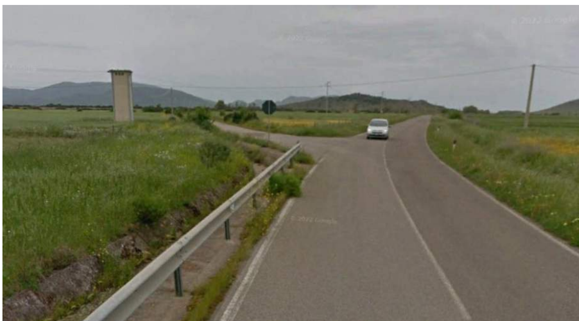
Figura 5.6 – SP65 con, sulla sinistra, la strada comunale “Pardu Atzei” di accesso al Sito (Fonte: Google Earth)
