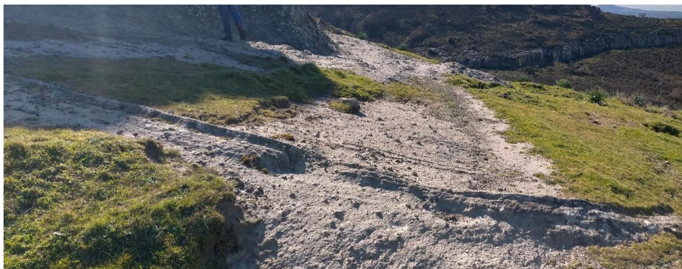
Figura 30 Erosione selettiva dovuta all'azione aggressiva dell'acqua nella roccia costituita da livelli di flusso piroclastico di differente competenza
