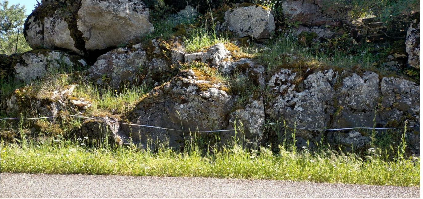
Figura 15 rilievo geostrutturale Scanline2.
