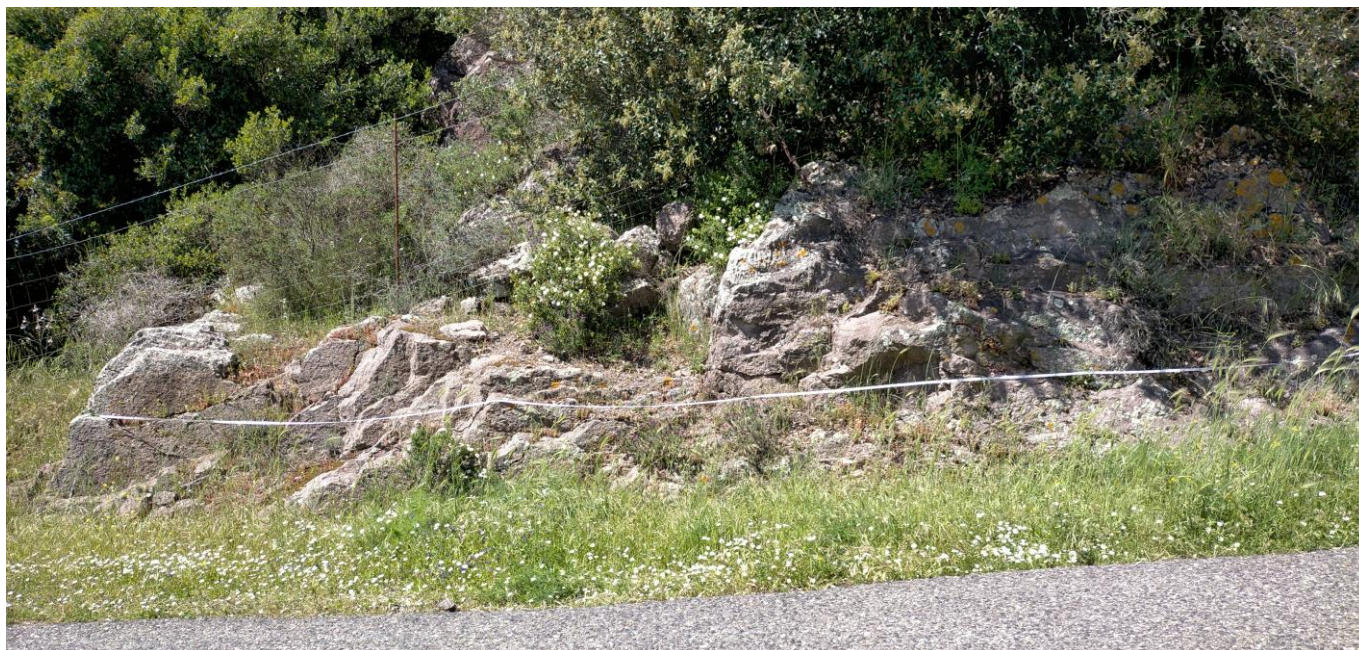
Figura 13 rilievo geostrutturale Scanline1.
