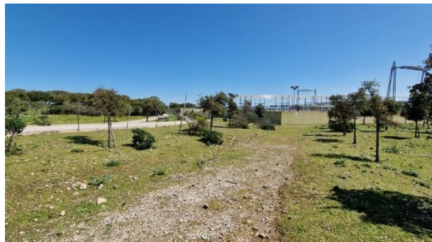
Figura 32. Area della Stazione di ampliamento, vista verso NE.
