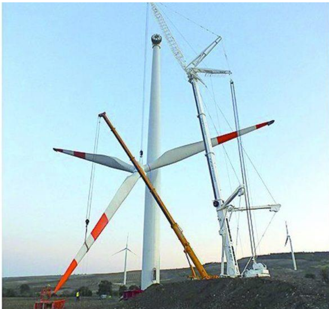
Figura 10: rappresentazione della fase di montaggio dell'aerogeneratore.
