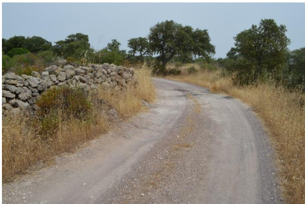
Figura 37 – Muretti a secco lungo tratto di viabilità da adeguare
