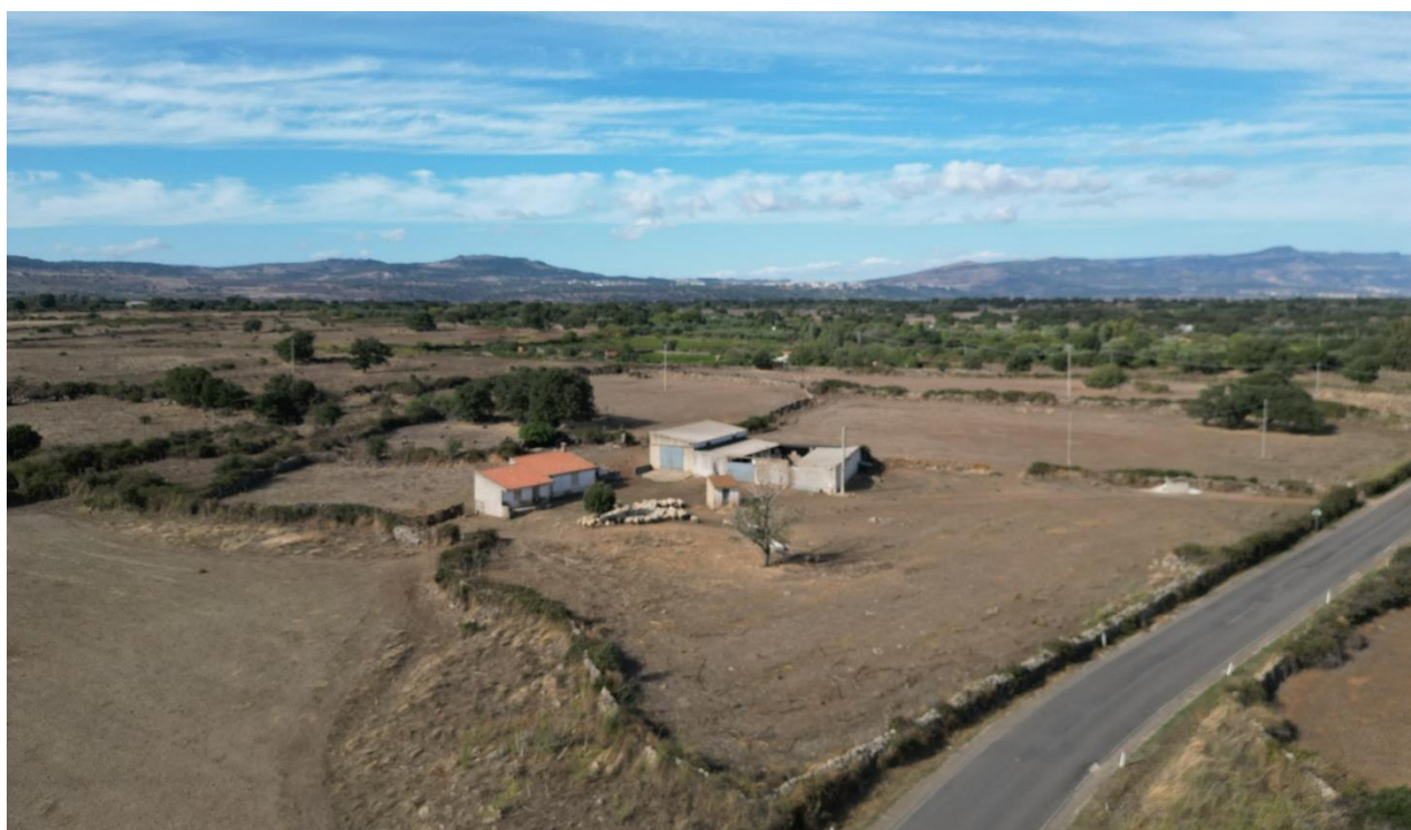
FIGURA 56: VISTA NORD-EST LOTTO 3
