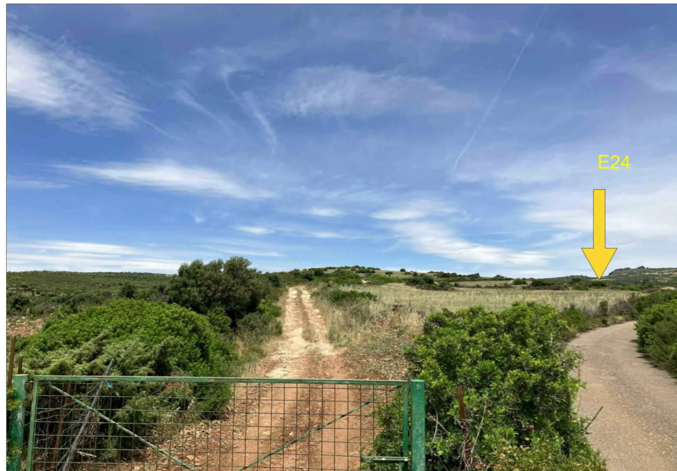
Foto Aerogeneratore E24
