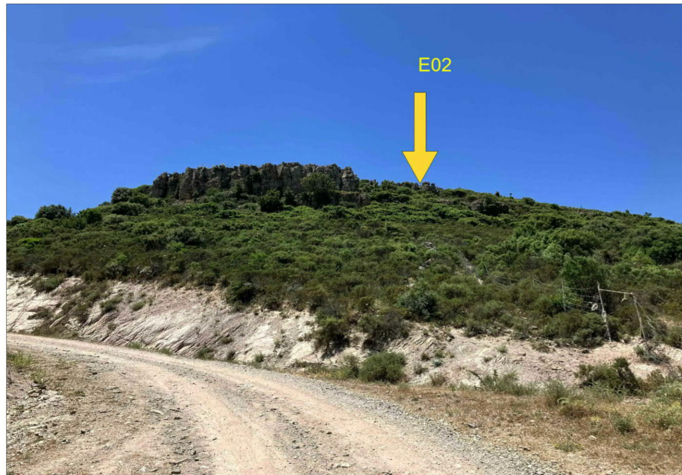
Foto Aerogeneratore E02
