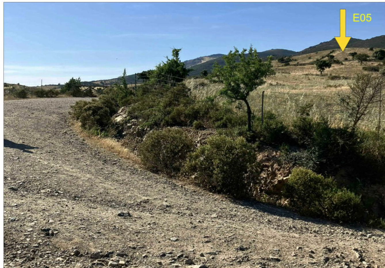
Foto Aerogeneratore E05
