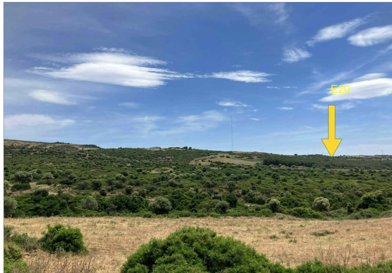
Foto Aerogeneratore E20
