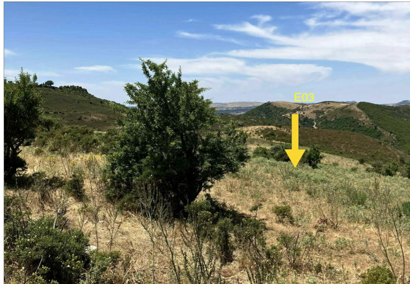
Foto Aerogeneratore E03
