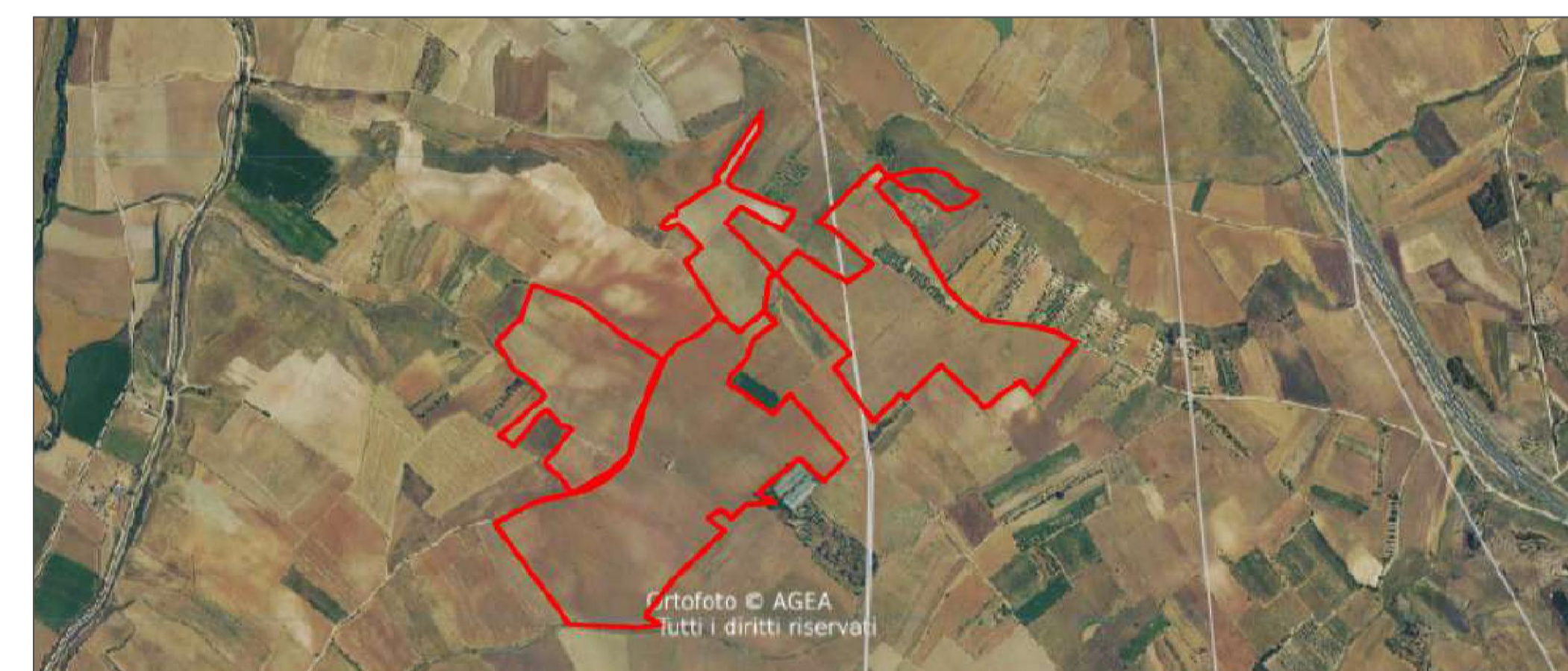
Reti e infrastrutture Linea elettrica Strada di impianto
