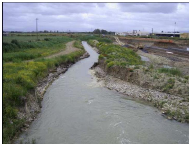
Fig. 46: Riu Flumini Mannu, realizzazione di una difesa di sponda in destra idrografica (maggio 2007).
