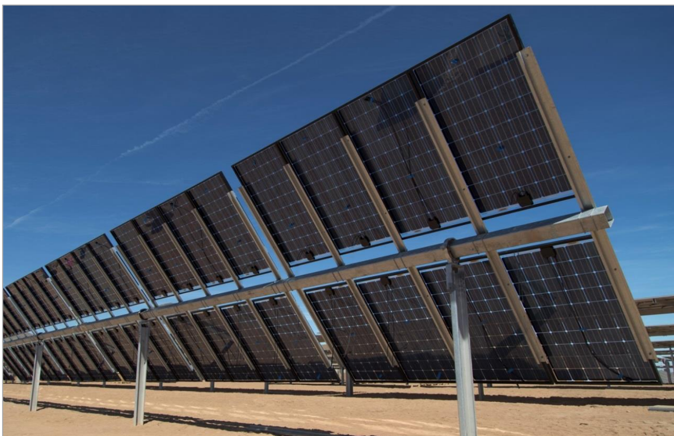
Figura.3- Esempio struttura + modulo FV bifacciale
