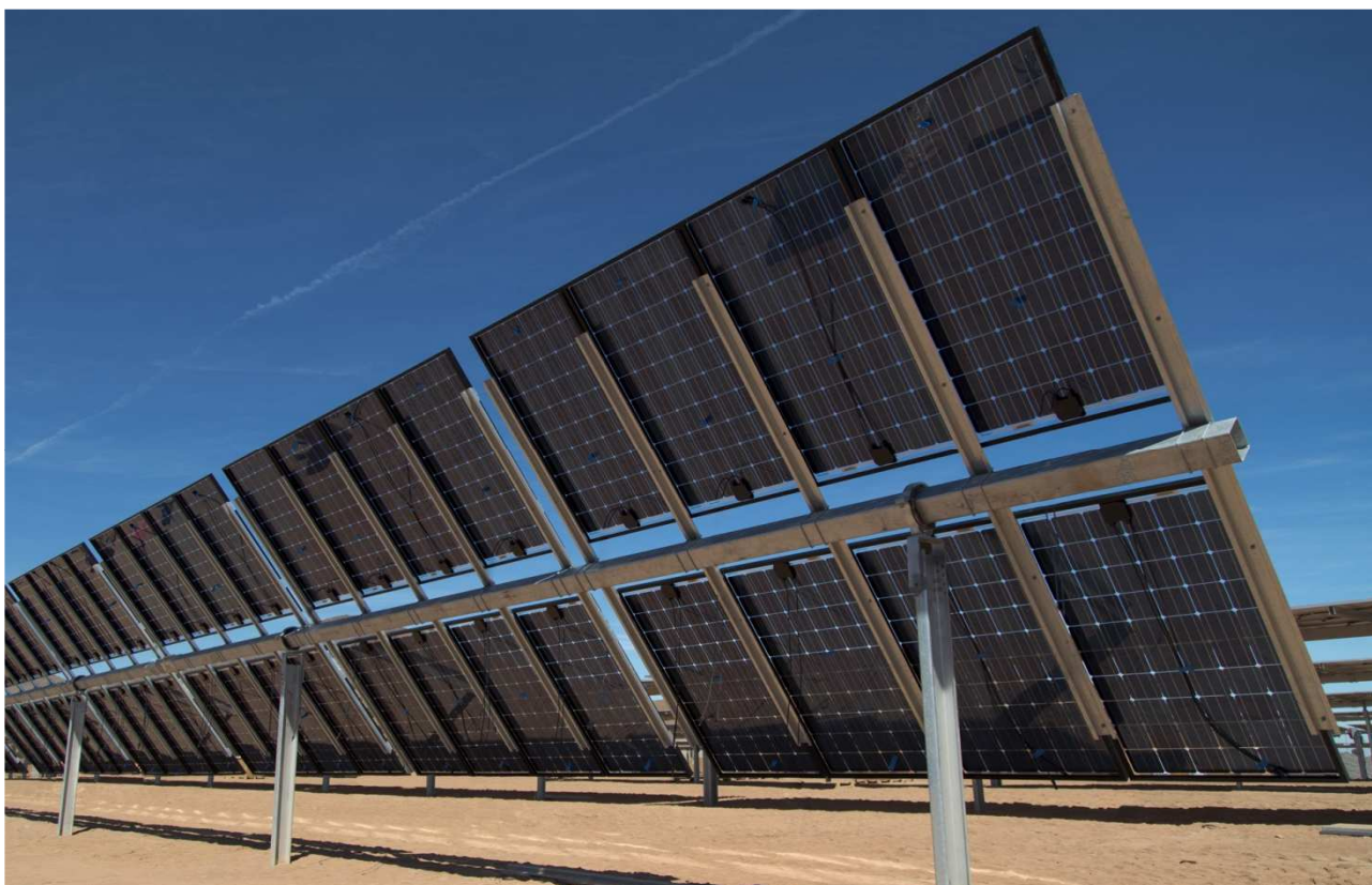
Figura 7.5: Esempio struttura e modulo FV bifacciale
