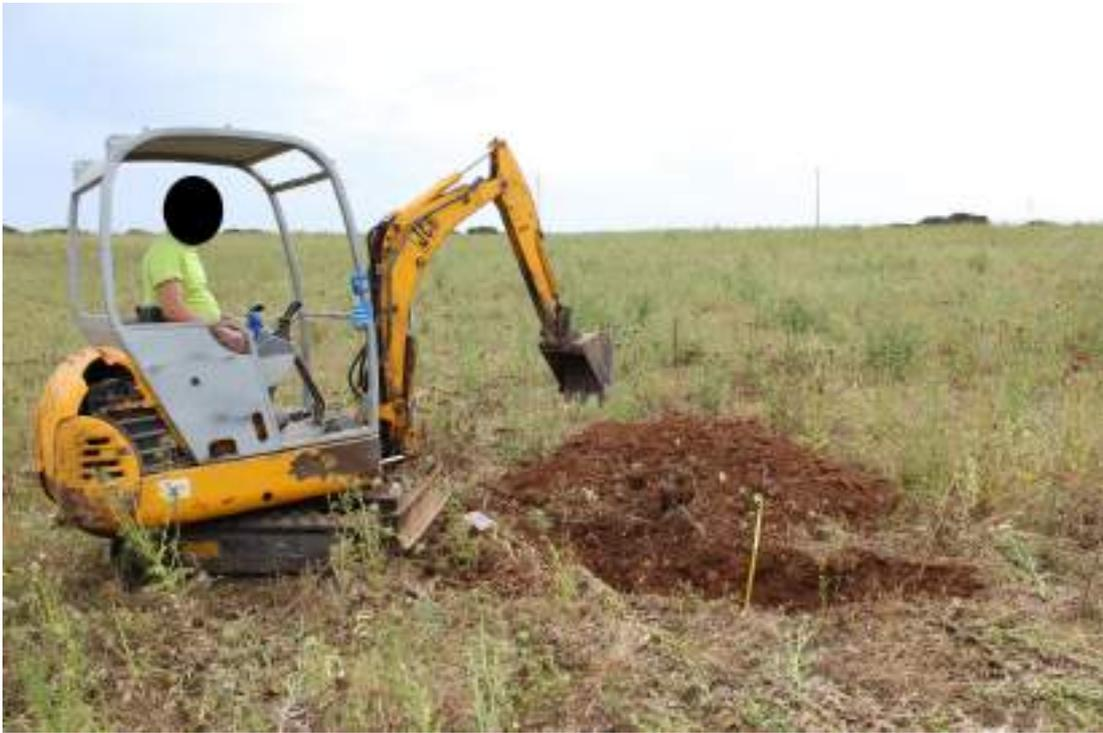
**Fig. 3: particolare posizionamento pozzetto geognostico Pz1.**
