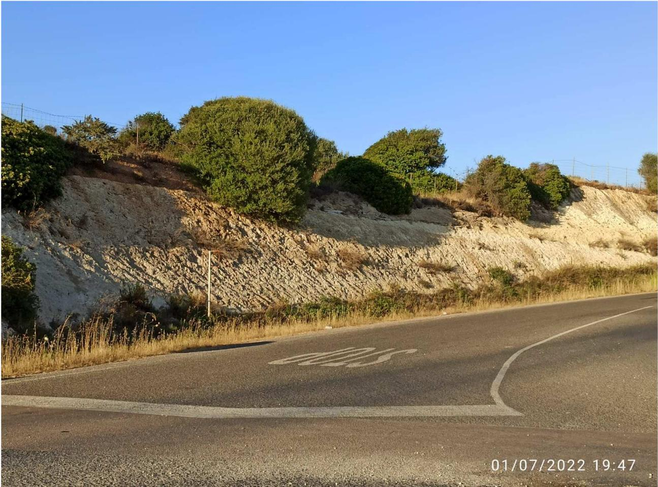
**Figura 5.14 - Substrato calcareo in affioramento su taglio stradale rappresentativo della formazione di mores in prossimità dell'incrocio incrocio Bancali-Li Punti (Strada Provinciale 132)**
