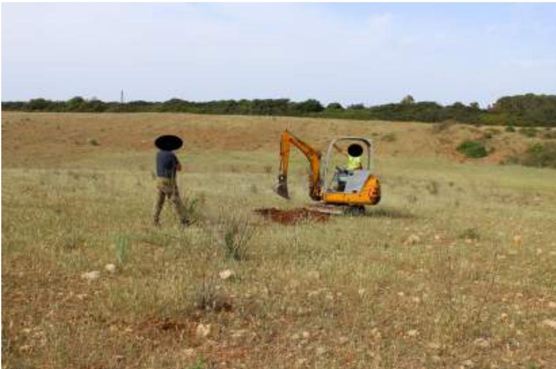
**Fig. 34: posizionamento pozzetto geognostico Pz20.**
