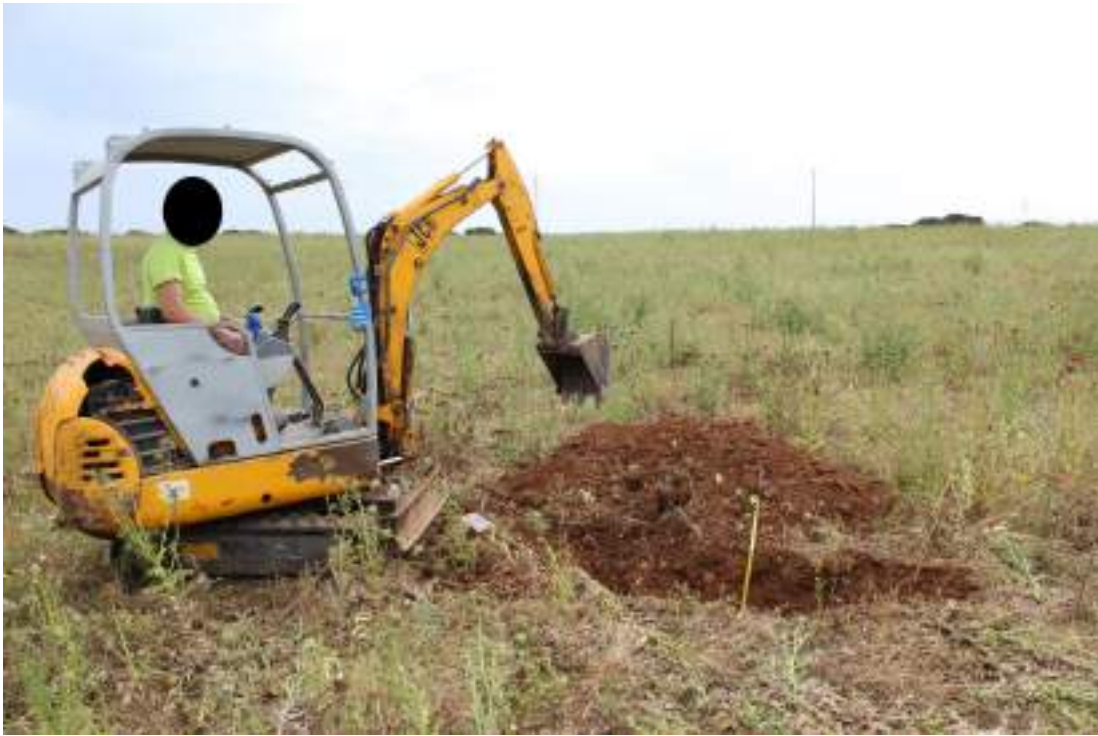
Fig. 3: particolare posizionamento pozzetto geognostico Pz1.
