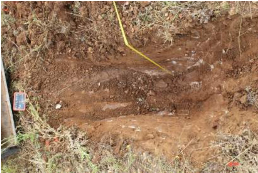
Fig. 1: esecuzione pozzetto geognostico Pz1 (prof.0,00 – 0,70 m dal p.c.)
