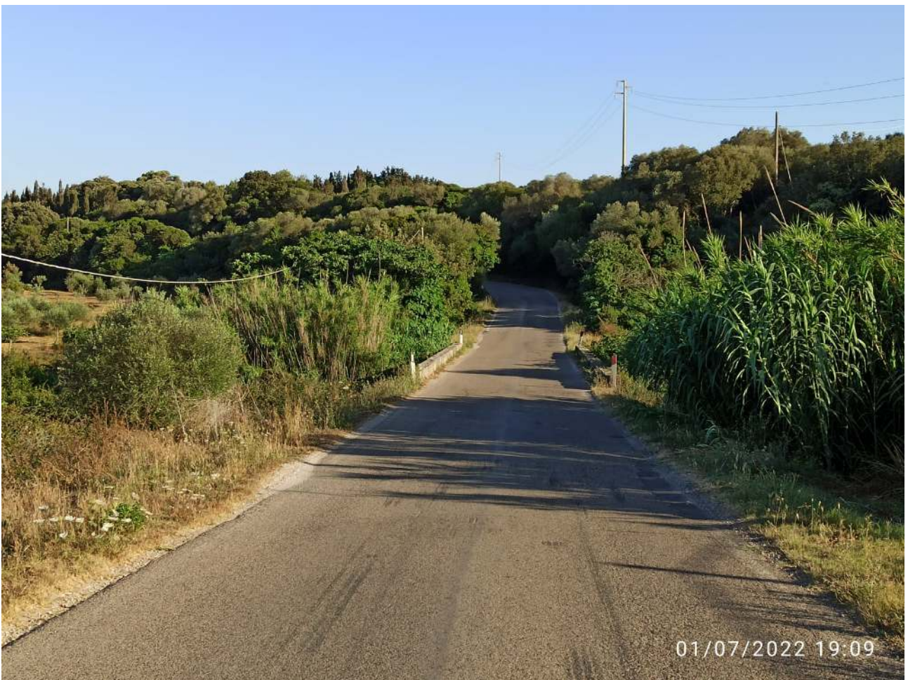
Figura 3.7 - Veduta del ponticello di attraversamento del Rio D'Ottava
