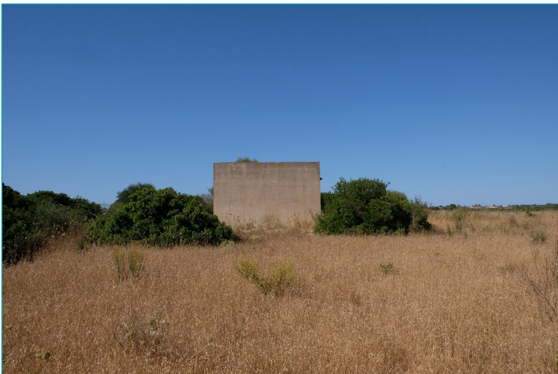
Figura 8.7 - Area EST. Struttura per il pompaggio di acqua in evidente stato di abbandono da molti anni.
