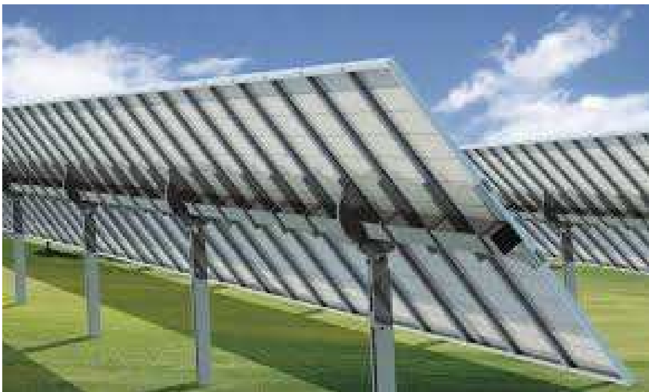
Figura 5.4 - Esempio di tracker fotovoltaico con vela tipo 2V
