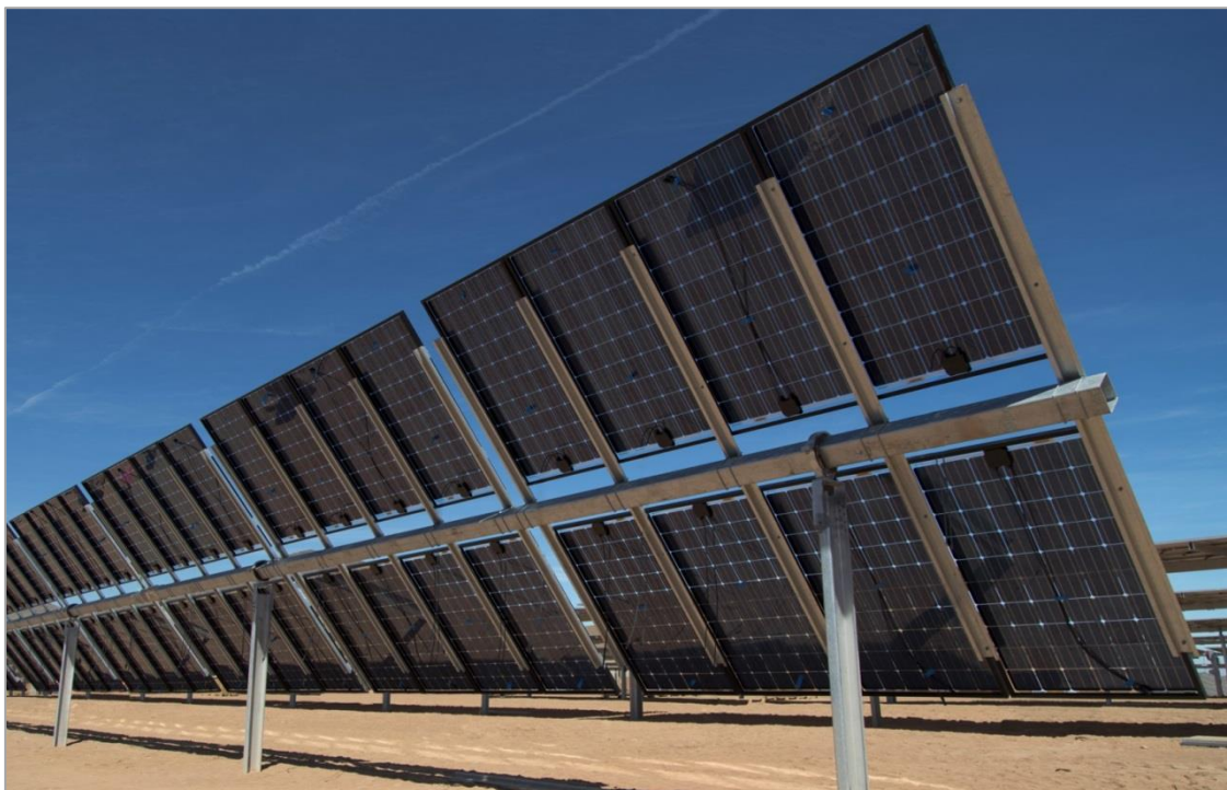
Figura III.3- Esempio struttura + modulo FV bifacciale
