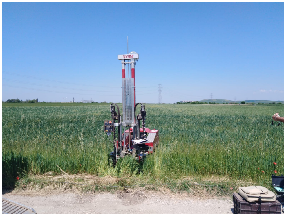
Prova Penetrometrica Dinamica Pesante DPSH 02
