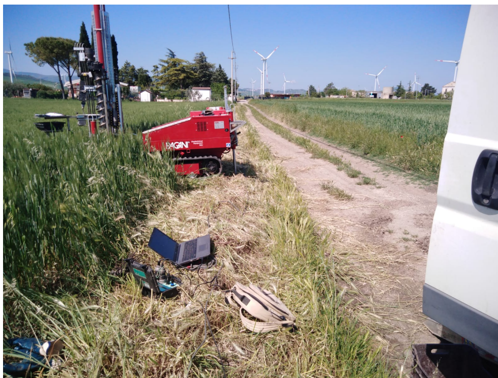
Prova Penetrometrica Dinamica Pesante DPSH 03
