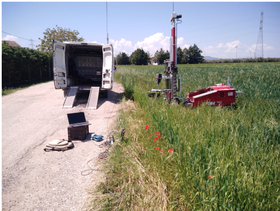
Prova Penetrometrica Dinamica Pesante DPSH 04
