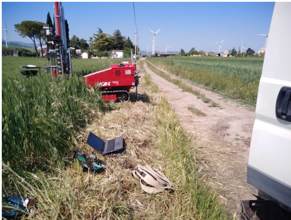
Prova Penetrometrica Dinamica Pesante DPSH 03
