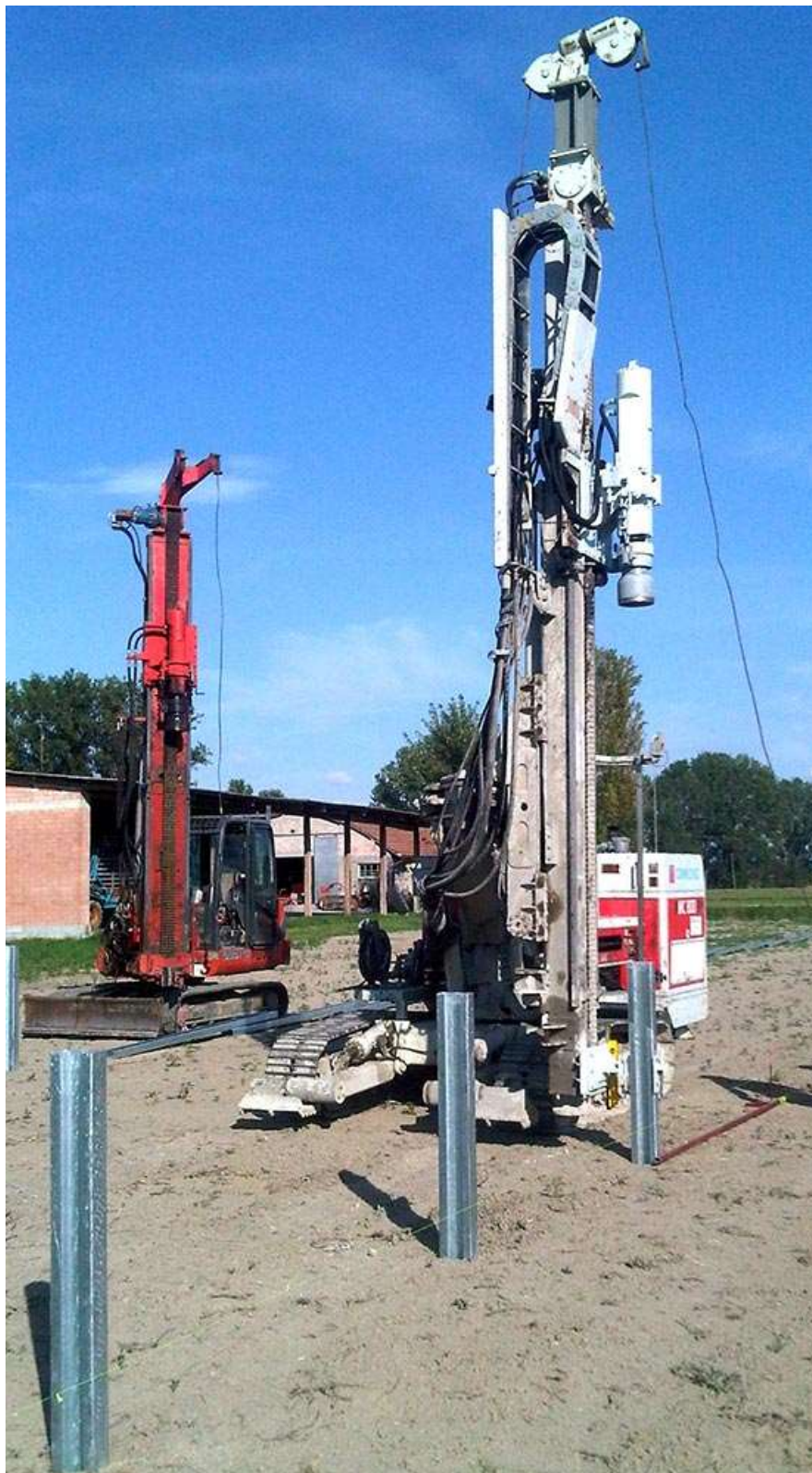
Figura 2.2: Esempio di Macchina Operatrice Battipalo
