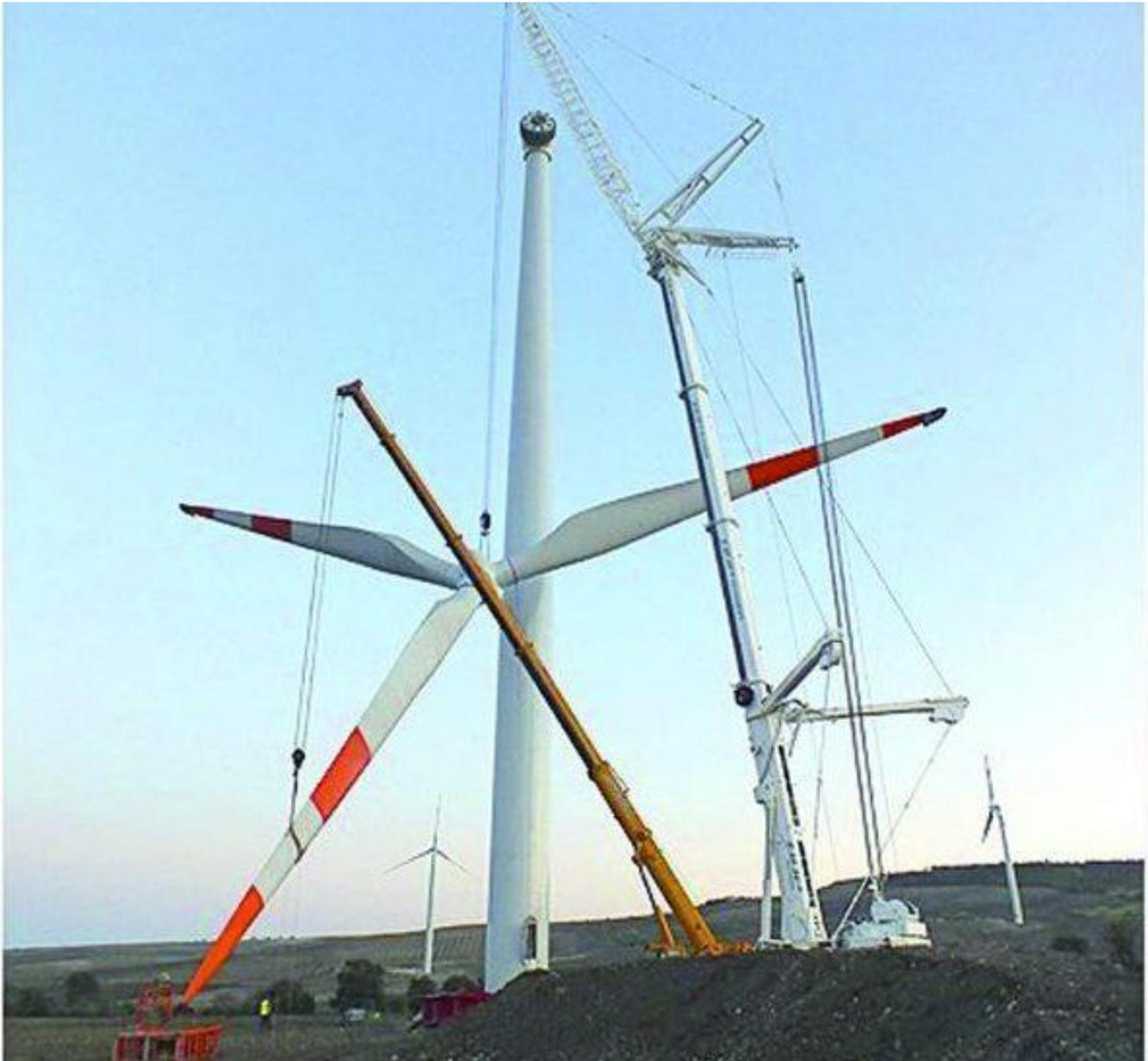
**Figura 10: rappresentazione della fase di montaggio dell'aerogeneratore.**
