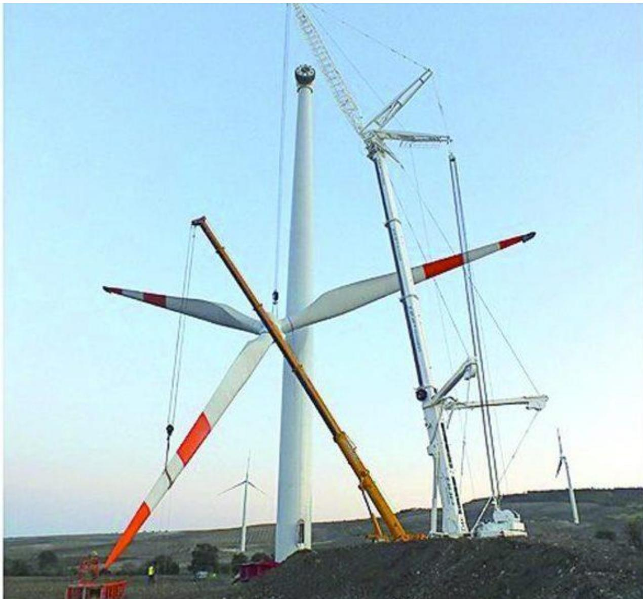
**Figura 10: rappresentazione della fase di montaggio dell'aerogeneratore.**
