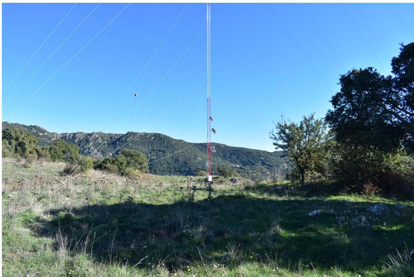
Figura 14 – Vista in direzione E delle superfici in cui è prevista la realizzazione della stazione eolica AG03 in cui attualmente è presente la stazione anemometrica
