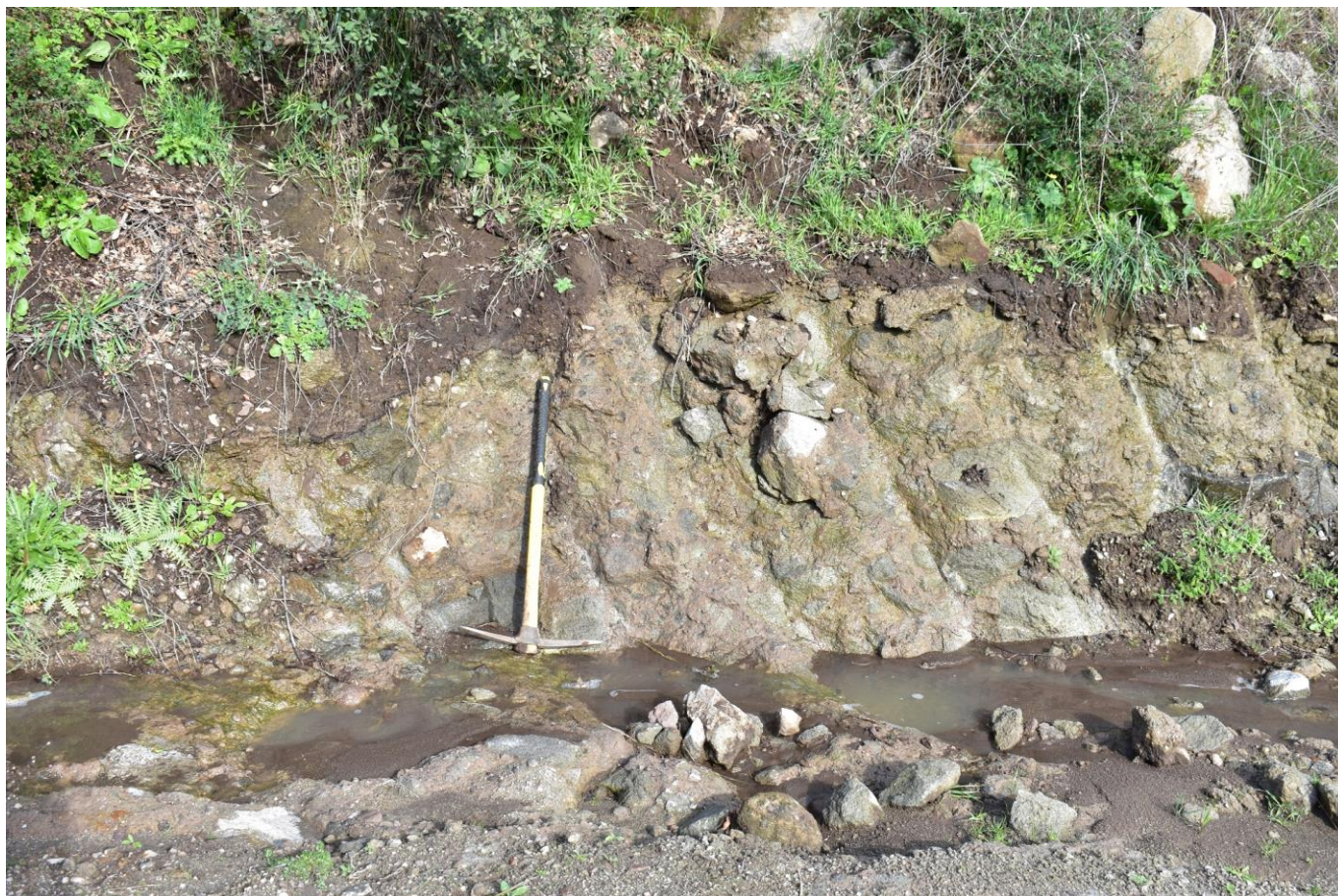
Figura 33 – Taglio stradale a valle della stazione AG08 è possibile apprezzare la sottile copertura di suolo che ricopre la roccia madre e lungo il rivolo sono visibili le aree di deposito della frazione fine asportata a monte. Questo suolo è inevitabilmente perso e si accumulerà nel fondovalle.
