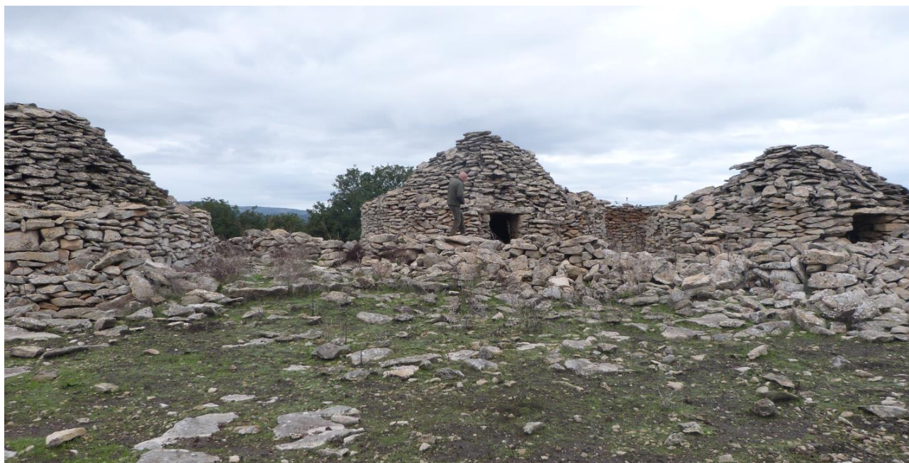
Figura 48. Le particolari ed interessanti strutture ricovero pastorali, " pinnettas ", costituiscono potenziali rifugi per piccola fauna selvatica, compresi i Chiroteri. Durante i numerosi rilievi però non sono stati rilevati roost particolari.
