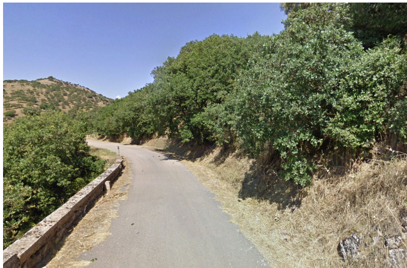
Figura 13 Strada provinciale SP77 visione stradale. L'immagine è diretta verso nord.
