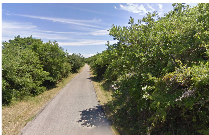
Figura 14 Strada provinciale SP61 visione stradale. L'immagine è diretta verso nord.
