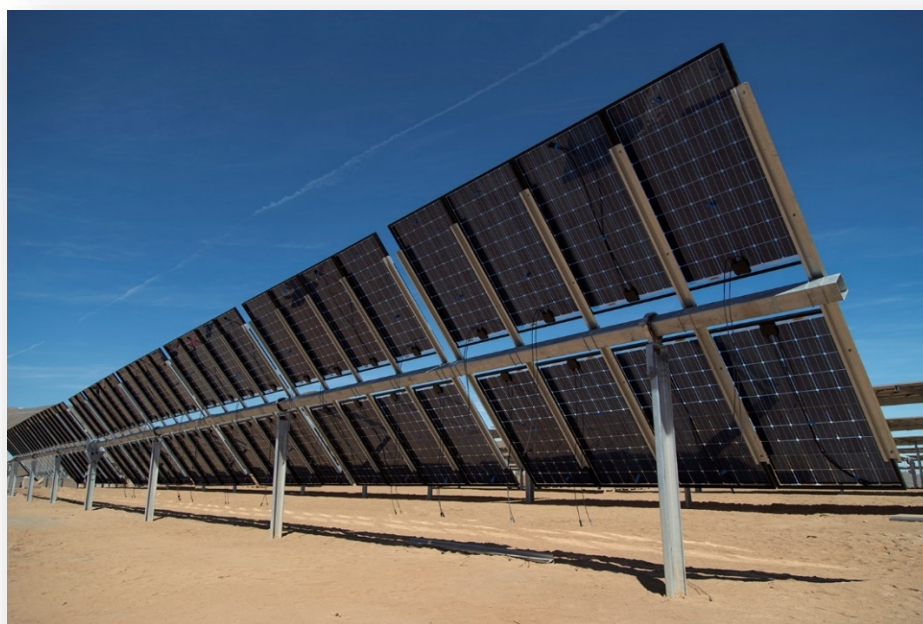
Figura 1 – vista prospettica inseguitore solare monoassiale
