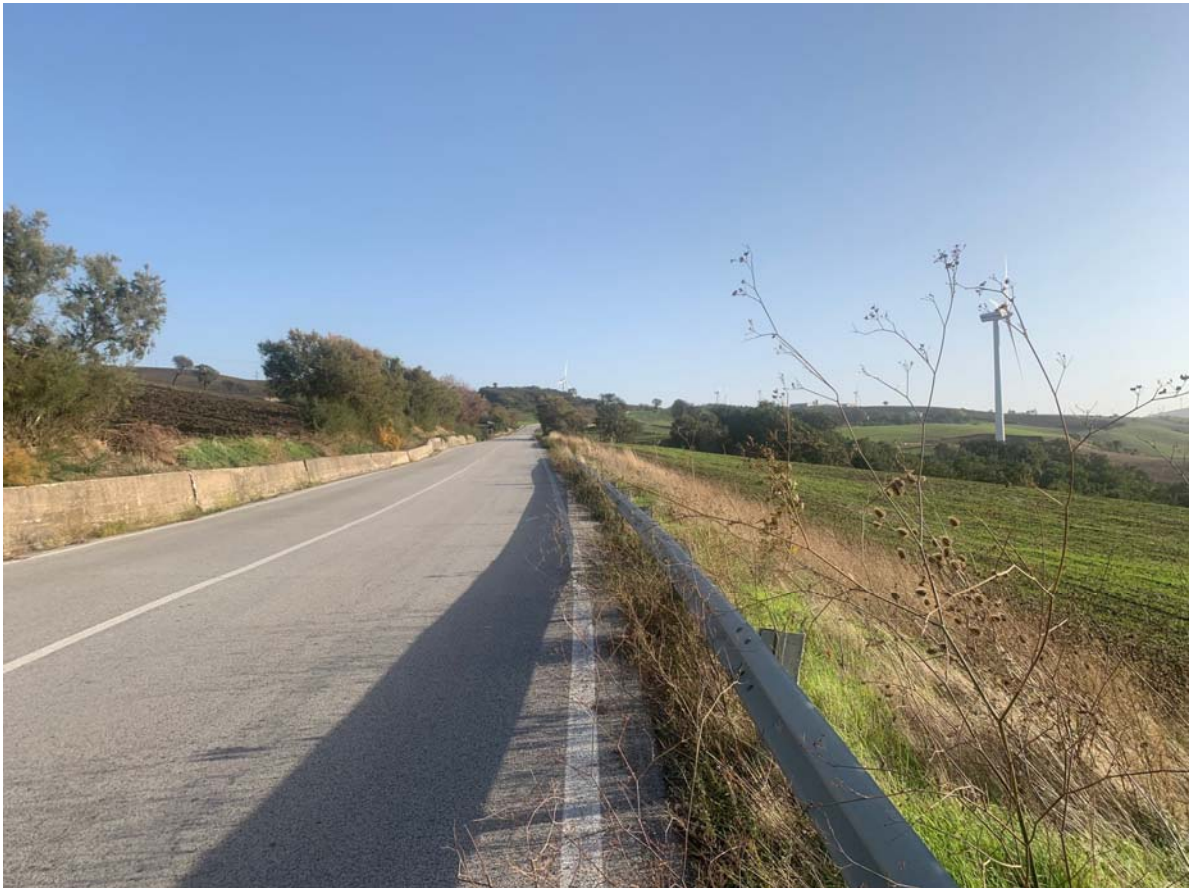
Punto di scatto - 2 Stato Ante Operam
