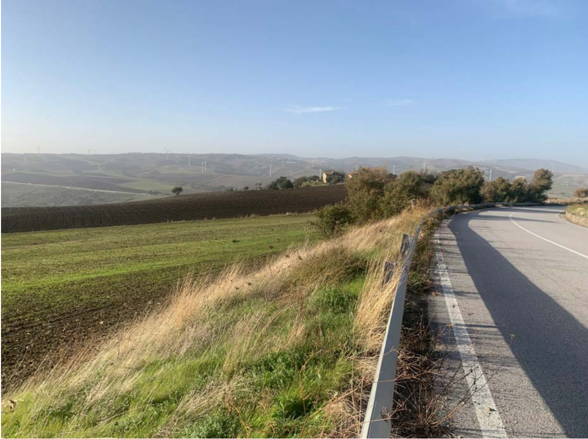
Punto di scatto 1 - Stato Ante Operam
