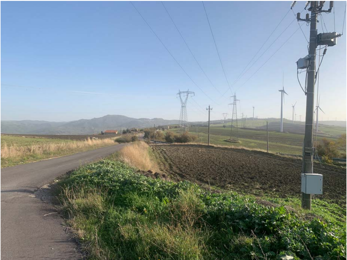
Punto di scatto - 5 Stato Ante Operam
