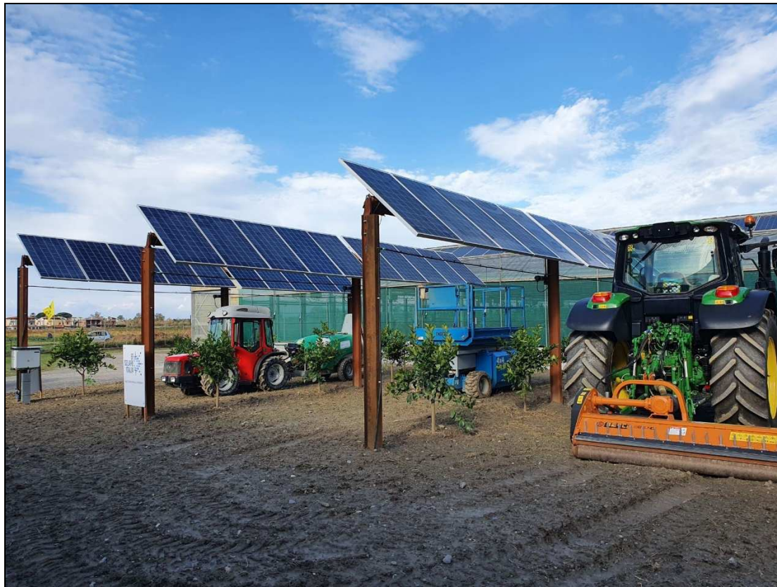
Figura 13. Inseguitore monoassiale con integrazione agro-voltaica (fonte: Convert Italia).
