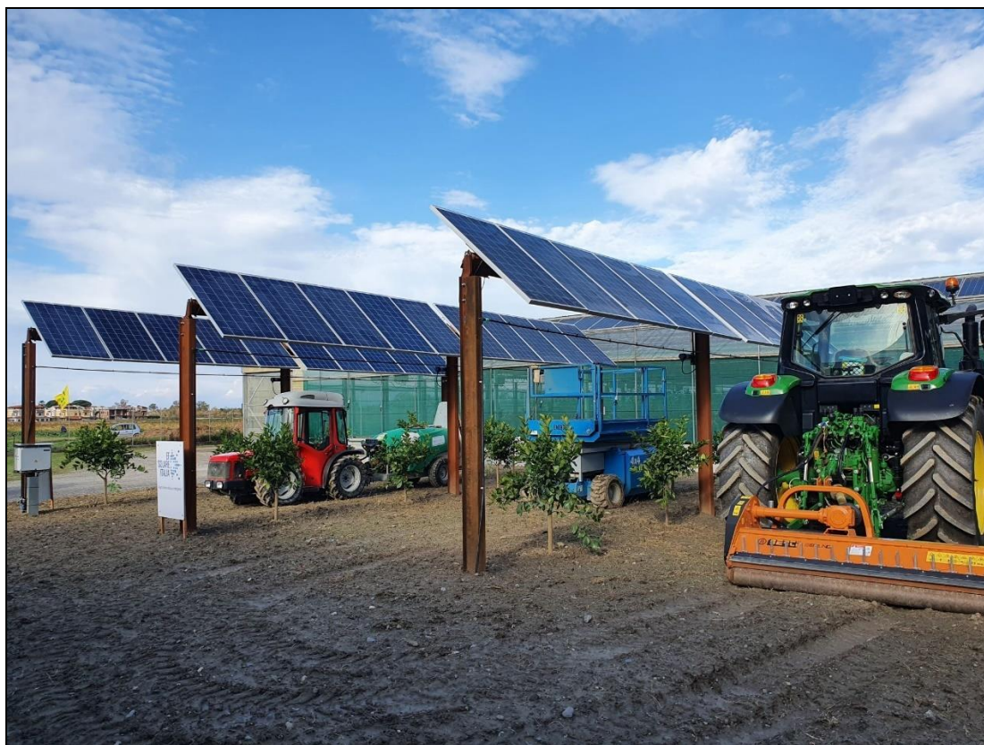
Fig. 5. Inseguitore monoassiale con integrazione agro-voltaica (fonte: Convert Italia)..
