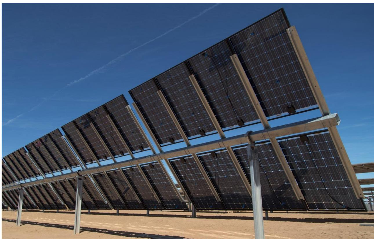
**Figura 7.5: Esempio struttura e modulo FV bifacciale**
