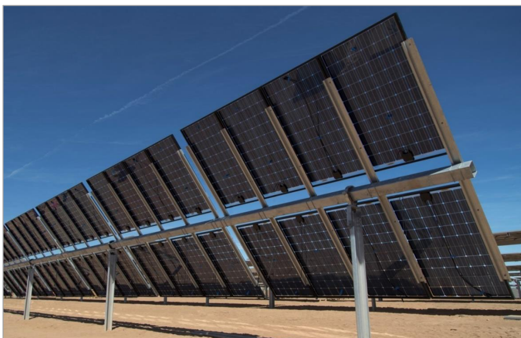
Figura.3- Esempio struttura + modulo FV bifacciale
