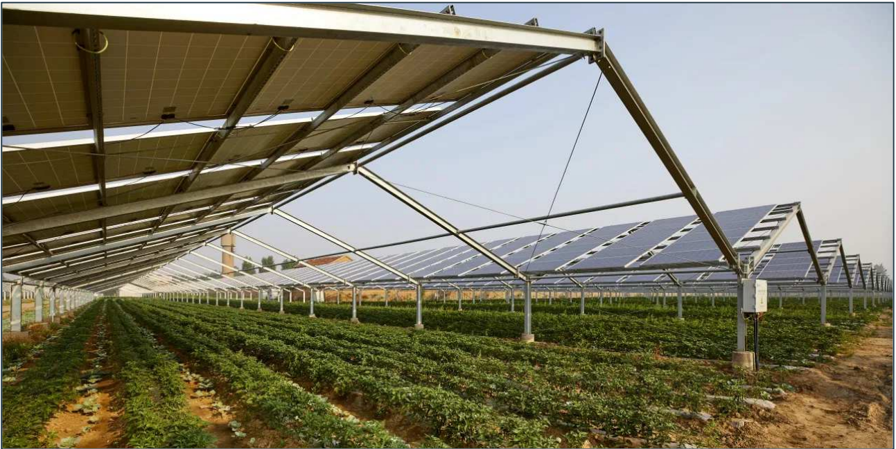
Figura 9.2 – Agro-fotovoltaico a moduli fissi con struttura a falde in Cina, in un campo coltivato a bacche di Goji
