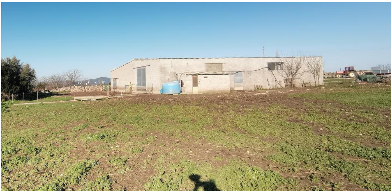
Figura III.7- Edificio esistente per il ricovero dei mezzi agricoli, ubicato nell'area N. 1
