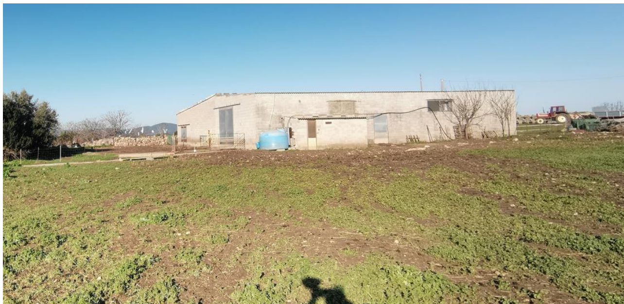
Figura 10- Edificio esistente per il ricovero dei mezzi agricoli, ubicato nell'area N. 1
