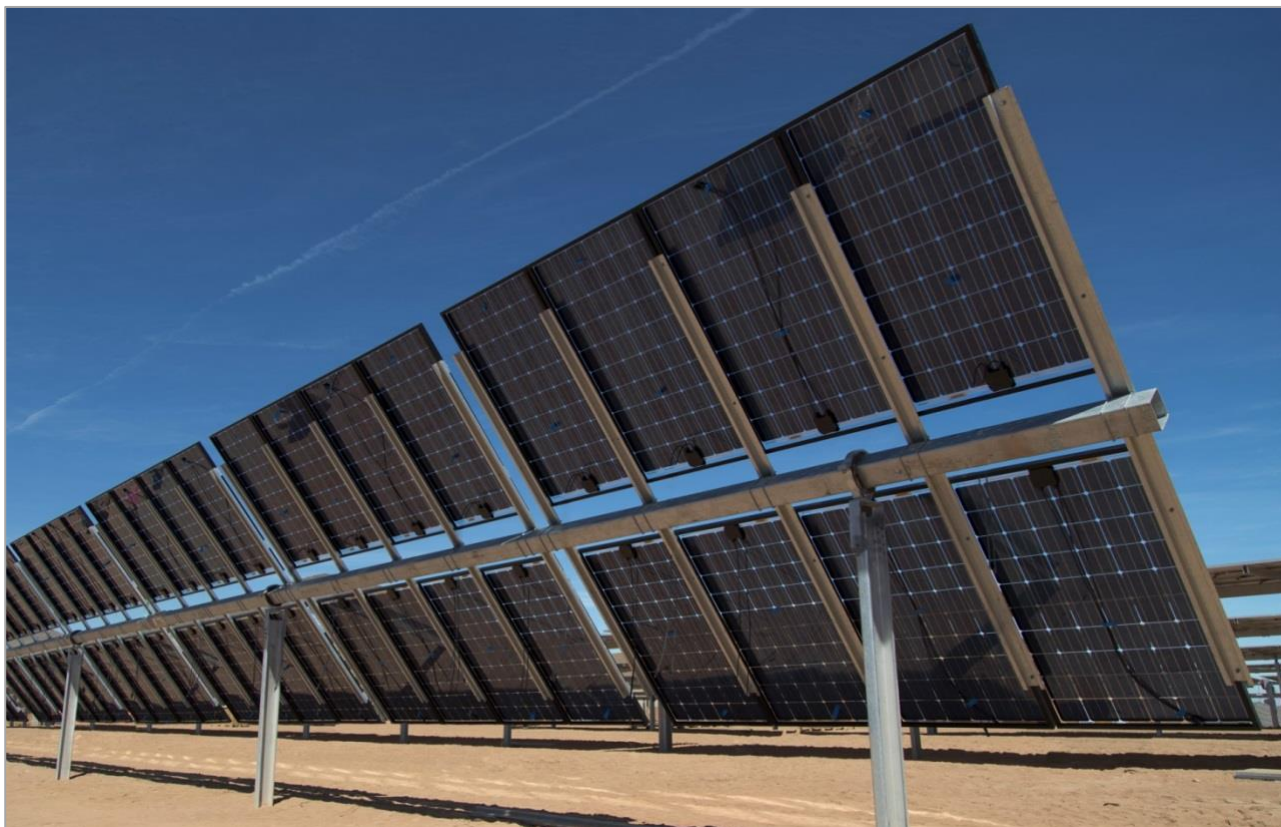
Figura 6- Esempio struttura + modulo FV bifacciale
